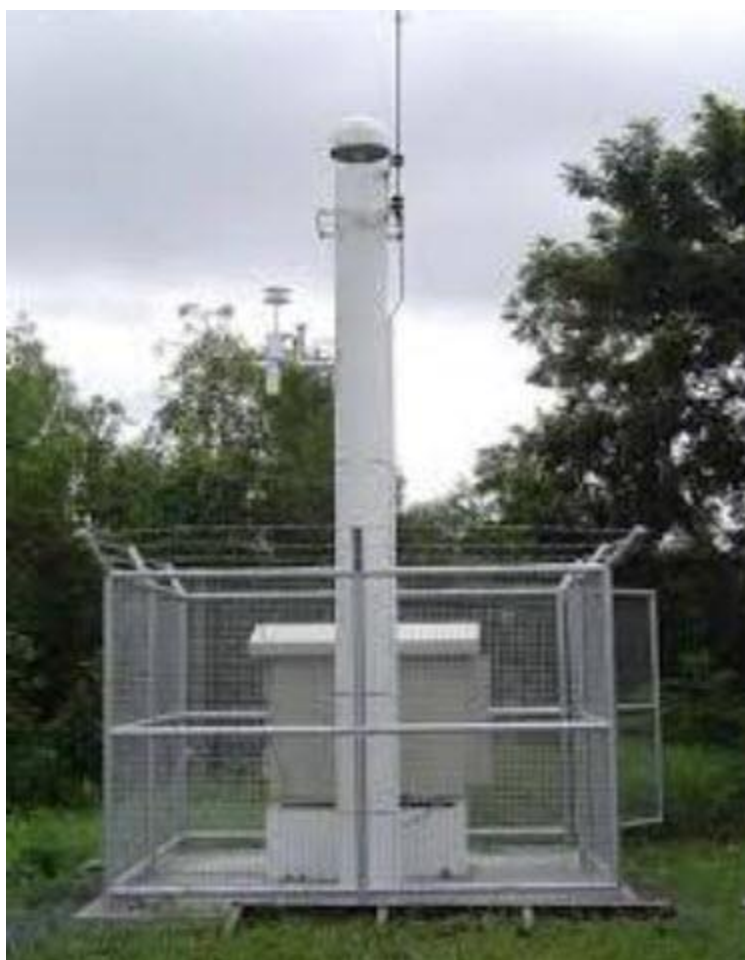
รูปที่ 2. 1 แสดงภาพสถานีรับสัญญาณดาวเทียมแบบต่อเนื่องของกรมโยธาธิการและผังเมือง
