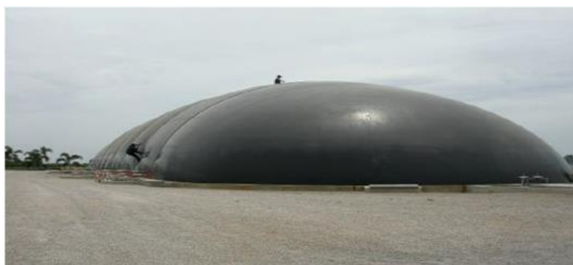
รูปที่ 2- 7 ภาพลักษณะของ Covered Lagoon (จันทแพน, 2014)
