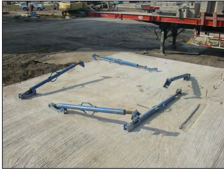
รูปที่ 4.24 การติดตั้งอุปกรณ์ค้ำยันบนแผ่นพื้น
