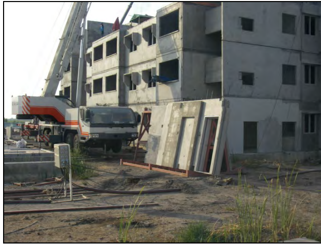
รูปที่ 4.21 การจัดเก็บแผ่นผนังคอนกรีตสำเร็จรูปภายในหน่วยงานติดตั้งชิ้นงาน
