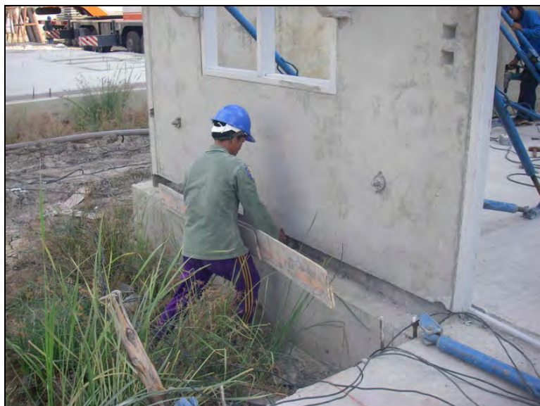
รูปที่ 4.32 การติดตั้งไม้แบบเพื่อตกแต่งรอยต่อระหว่างชั้นงาน
