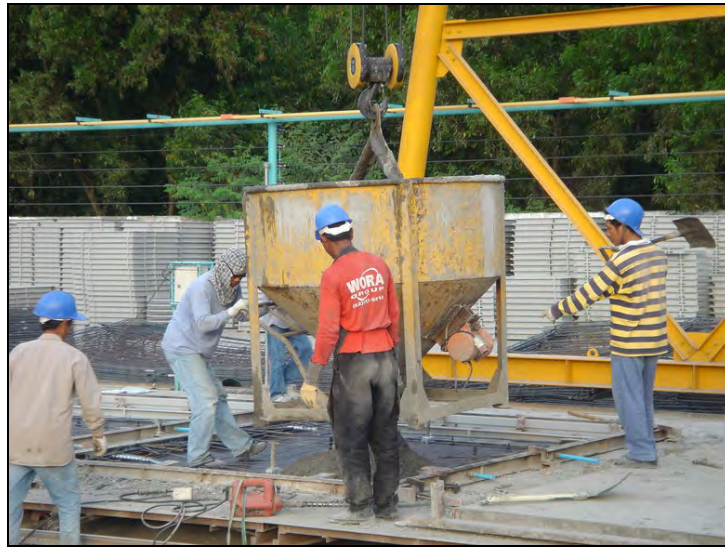
รูปที่ 4.10 การเทคอนกรีตลงในแบบหล่อ
