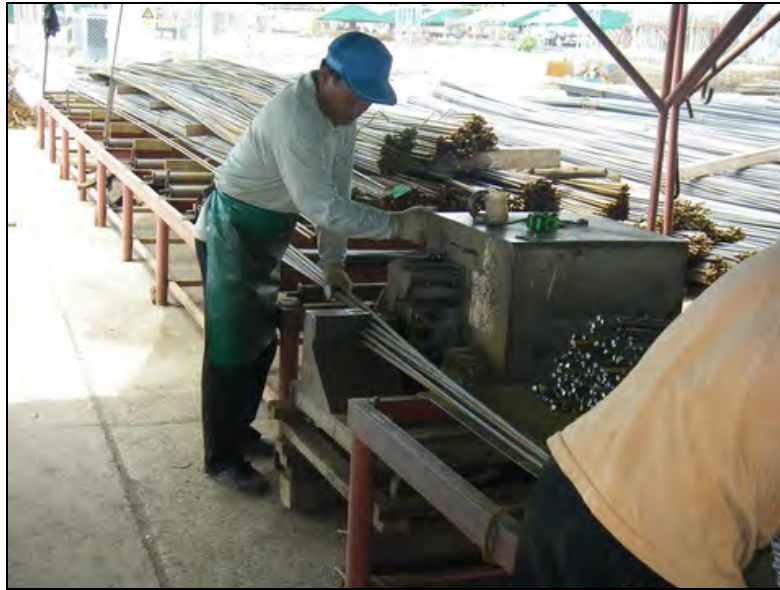
รูปที่ 4.5 การตัดเหล็กเสริมให้ได้ขนาดตามที่ต้องการ
