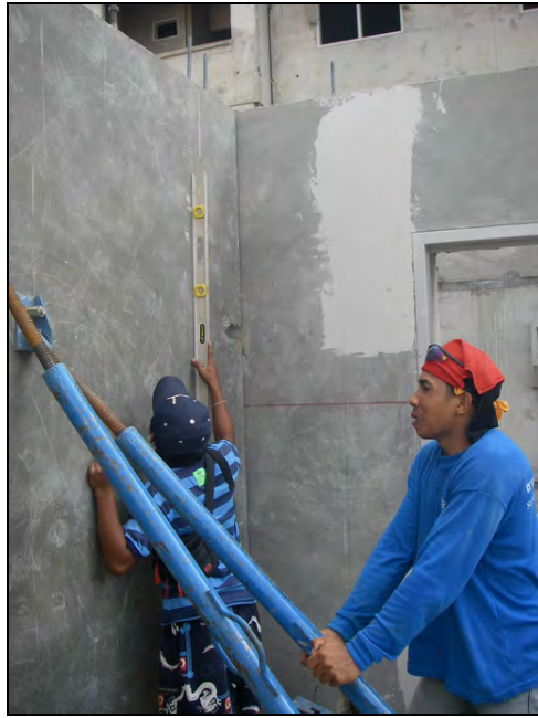
รูปที่ 4.28 การตรวจสอบระดับแนวตั้งของแผ่นผนังขณะติดตั้ง
