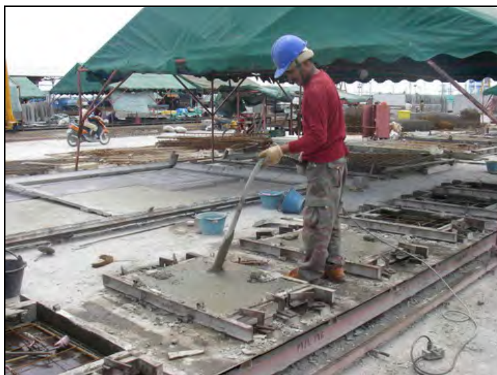
รูปที่ 4.11 การจี้คอนกรีตภายในแบบหล่อ
