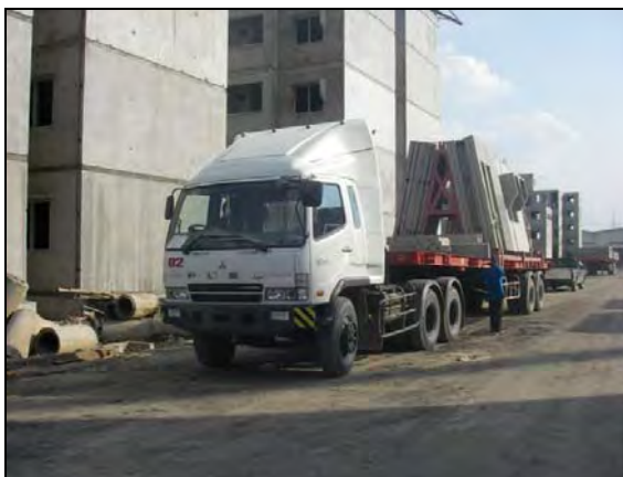
รูปที่ 4.20 การตรวจรับชิ้นส่วนคอนกรีตสำเร็จรูปเมื่อจัดส่งถึงหน่วยงานติดตั้งชิ้นงาน
