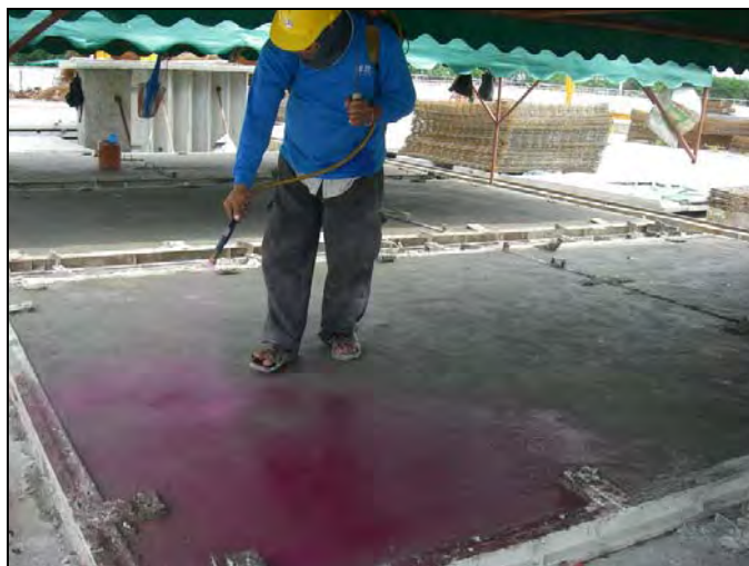
รูปที่ 4.15 การฉีดพ่นน้ำยาบ่มคอนกรีตลงบนชั้นงาน
