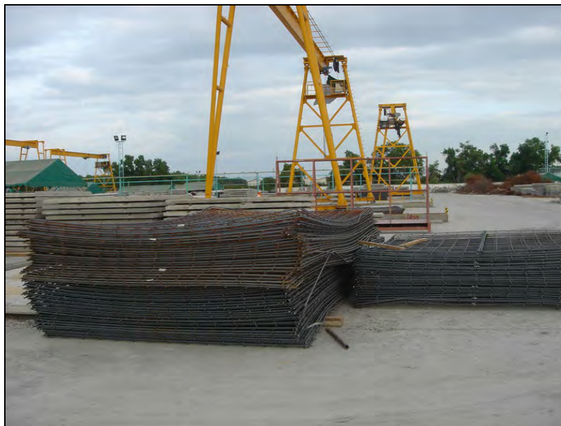
รูปที่ 4.8 การจัดเก็บเหล็กเสริมที่ทำจัดเตรียมแล้วเสร็จ
