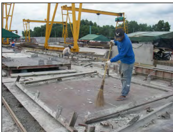
รูปที่ 4.2 การทำความสะอาดแบบหล่อ
