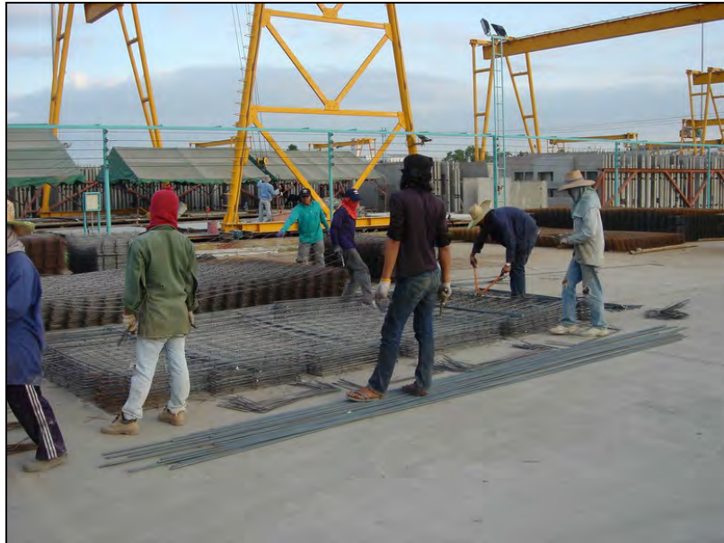
รูปที่ 4.7 การผูกเหล็กเสริมให้มีรูปทรงตามที่กำหนด
