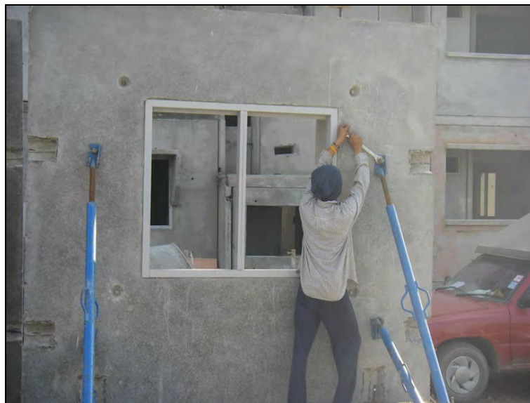
รูปที่ 4.27 การติดตั้งอุปกรณ์ค้ำยันที่แผ่นผนัง
