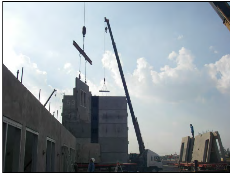
รูปที่ 4.25 การยกแผ่นผนังเพื่อทำการติดตั้ง
