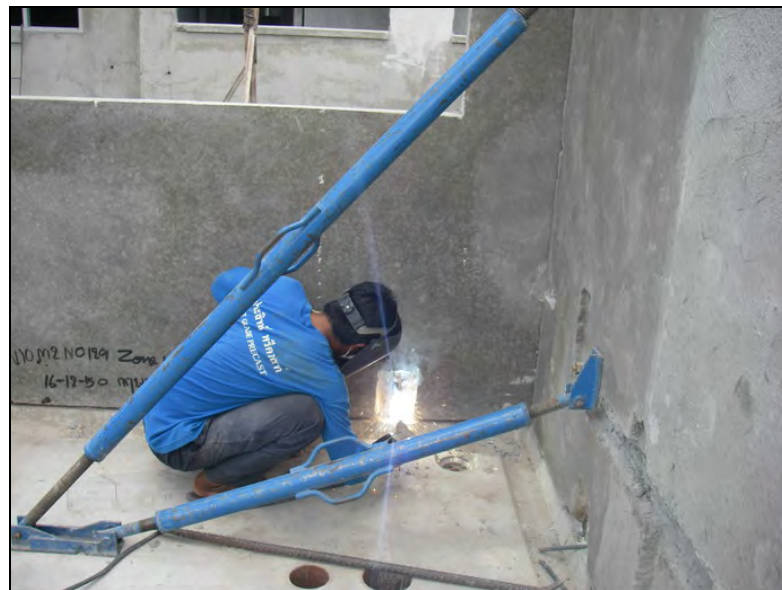
รูปที่ 4.29 การเชื่อมรอยต่อระหว่างชิ้นงาน
