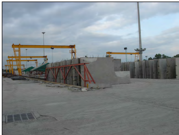
รูปที่ 4.18 สภาพชิ้นงานที่ถูกจัดเก็บรอการจัดส่งภายในพื้นที่หน่วยงานผลิตชิ้นงาน
