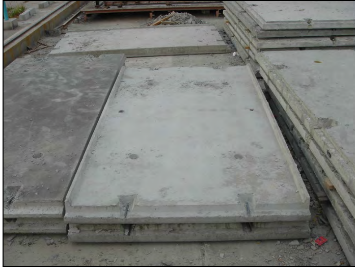
รูปที่ 4.14 ลักษณะผิวหน้าของชั้นงานแบบขัดมัน
