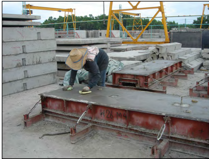
รูปที่ 4.12 การแต่งผิวหน้าคอนกรีต
