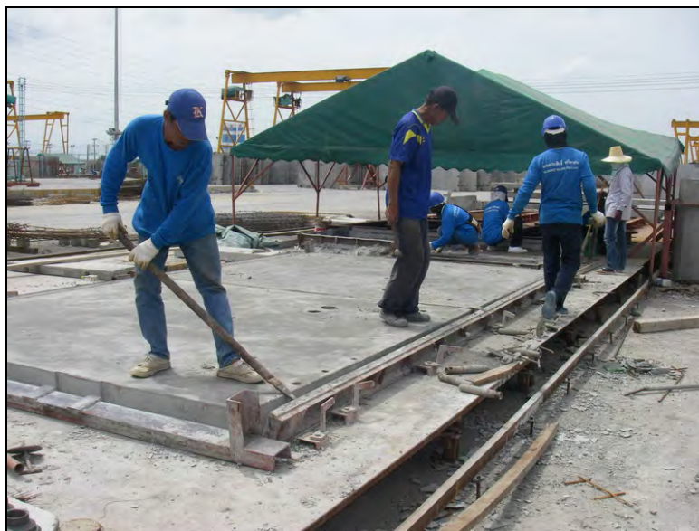
รูปที่ 4.16 การถอดแบบหล่อออกจากชิ้นงาน
