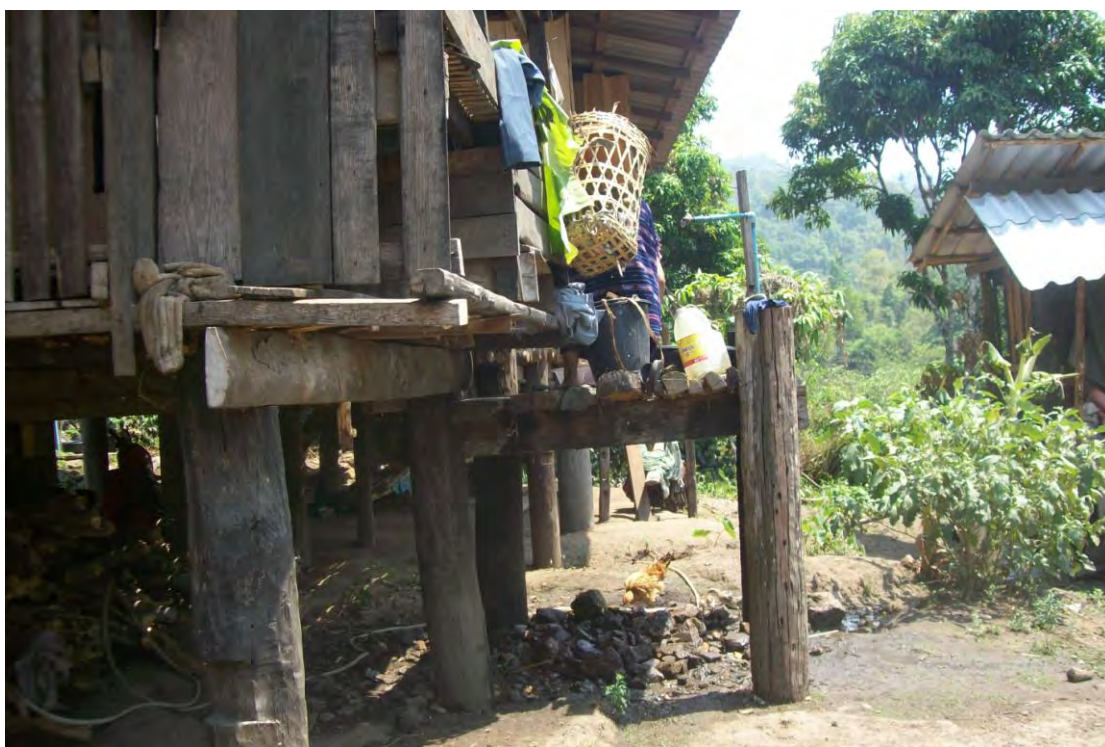
ลักษณะใต้ชานน้ำของสตรีท่านที่ 8 มีการบำบัดน้ำทิ้ง ไม่มีน้ำเน่าขัง
