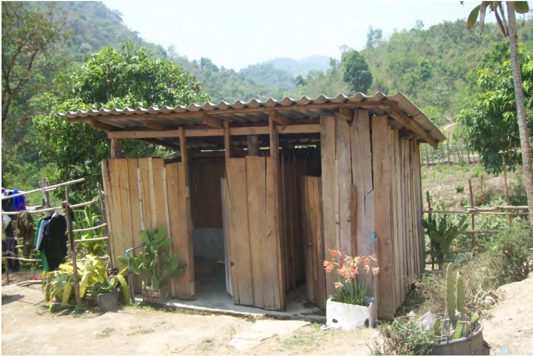
ห้องน้ำ-ห้องส้วมบ้านสตรีท่านที่ 4 ซึ่งสร้างใหม่เพิ่มขึ้น 2 ห้อง
