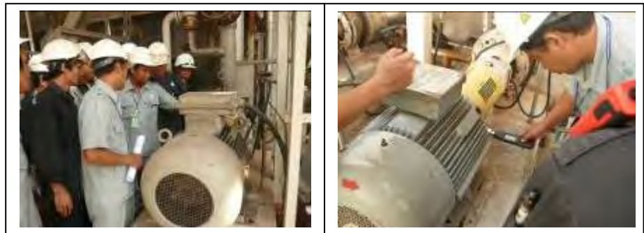
รูปที่ 6.5 การทำ PM มอเตอร์ไฟฟ้าภาคปฏิบัติการ
