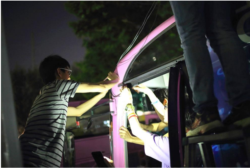
ภาพที่ ก.4 ภาพขณะทำการติดตั้งเสาสัญญาณและจีพีเอส
