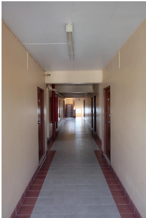
ภาพที่ 45 ทางเดินภายใน โครงการ เอ.ดับบลิว.เอส.คอร์ท
