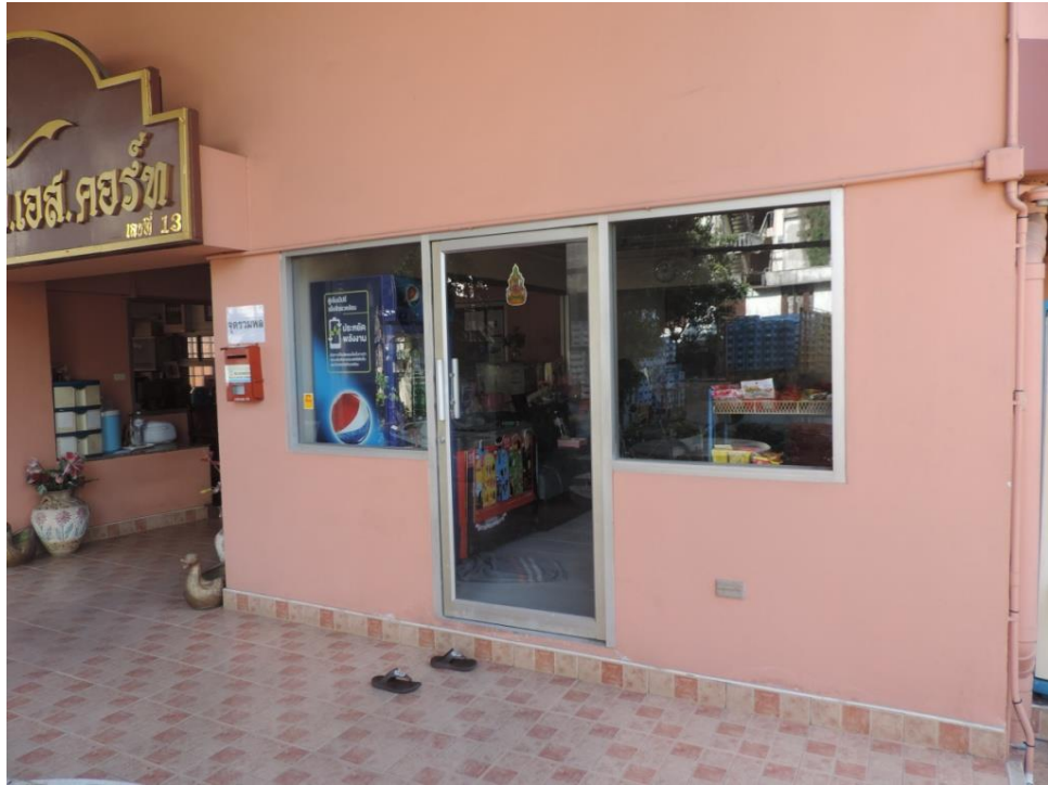
ภาพที่ 43 ห้องค้าภายใน โครงการ เอ.ดับบลิว.เอส.คอร์ท
