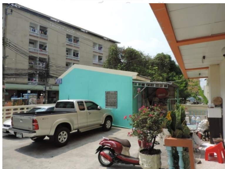
ภาพที่ 29 ลานจอดรถ โครงการศิริวัฒน์แมนชั่น
