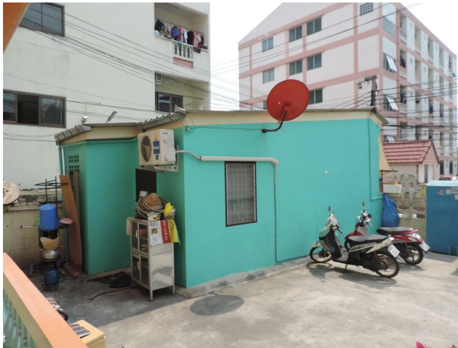
ภาพที่ 30 ด้านหลังห้องค้า โครงการศิริวัฒน์แมนชั่น
