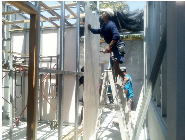
ภาพ 3.8 แสดงการติดตั้งผนังห้องจำลอง
