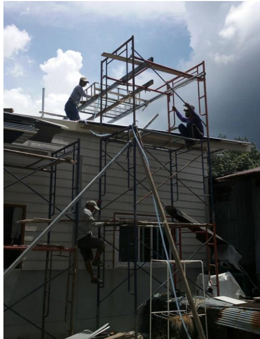
ภาพ 3.29 การติดตั้งกระเบื้องไว้เหนือหลังคาเป็นระยะ 1 เมตร
