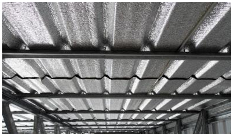
ภาพ 1.5 แผ่นหลังคาที่ติดตั้งด้วยฉนวน PE ปิดผิวด้วยแผ่นพอลิ
