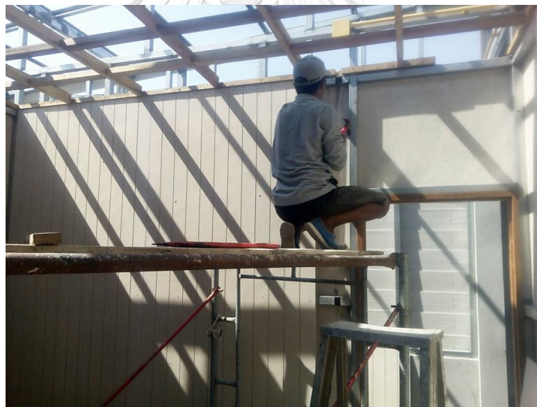
ภาพ 3.9 แสดงการติดตั้งผนังห้องจำลอง
