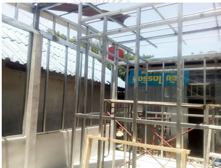
ภาพ 3.7 แสดงการติดตั้งโครงผนังห้องจำลอง
