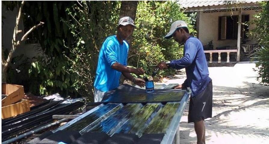
ภาพ 3.1 ทากาวบนแผ่นเหล็กมุงหลังและบนฉนวนยางดำ
