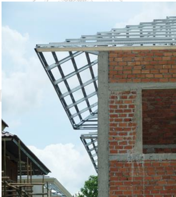
ภาพ 3.33 การติดตั้งเชิงชายเหล็กชุบกำลาไนซ์ ที่มา : ถ่ายโดยผู้วิจัย วันที่ 12 มกราคม 2561
