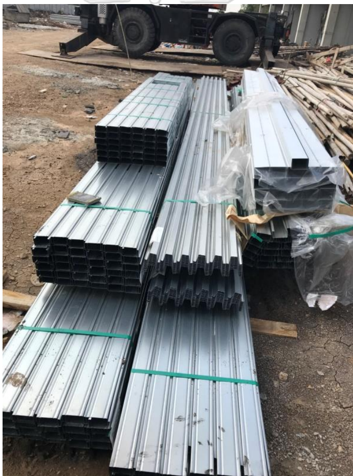
ภาพ 4.14 การกองเก็บชิ้นส่วนเหล็กชุบสังกะสีบริเวณสถานที่ก่อสร้าง ที่มา : ถ่ายโดยผู้วิจัย วันที่ 5 มกราคม 2561
