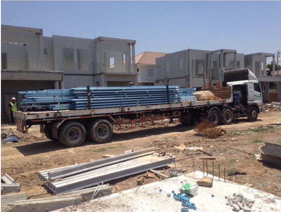
ภาพ 3.24 ขนส่งชิ้นส่วนเหล็กชุบสังกะสีมายังพื้นที่ก่อสร้าง
