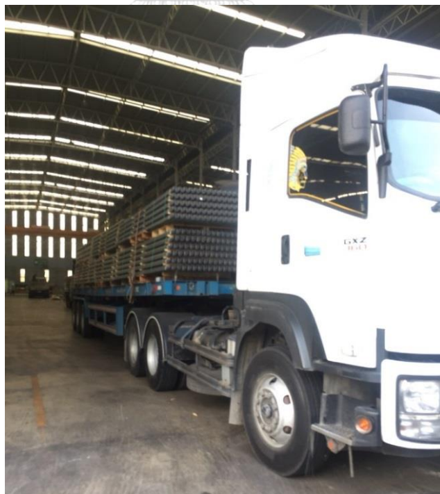
ภาพ 3.23 เตรียมขนย้ายชิ้นส่วนเหล็กชุบกลวไนซ์ไปยังพื้นที่ก่อสร้างโดยรถบรรทุก ที่มา : ถ่ายโดยผู้วิจัย วันที่ 5 มกราคม 2561
