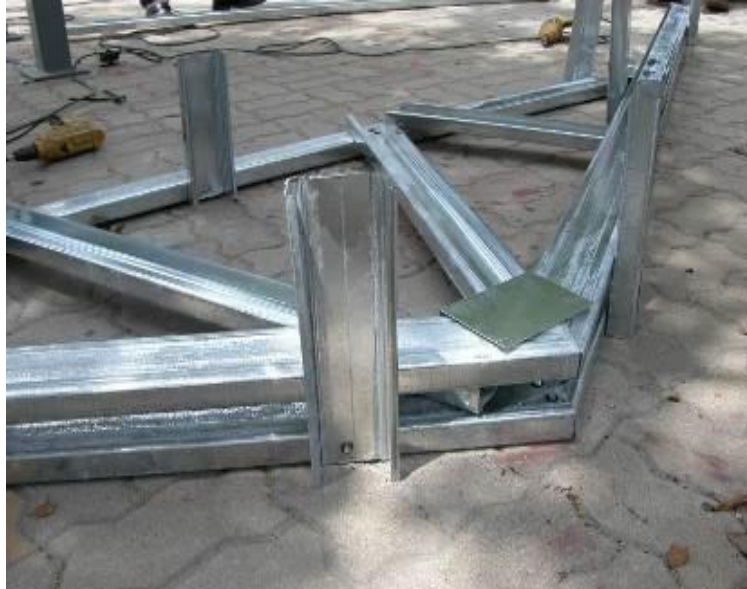
ภาพ 3.28 การประกอบโครงถักเหล็กชุบสังกะสี
