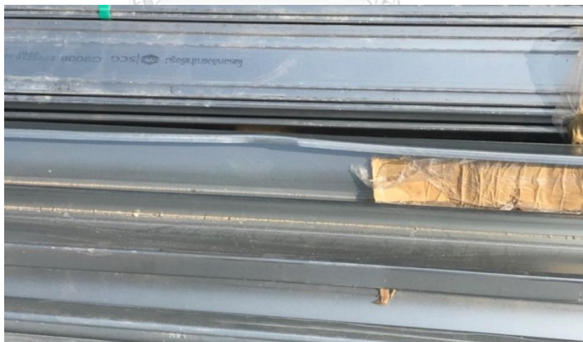
ภาพ 6.4 ปัญหาเรื่องความเสียหายของชิ้นส่วนเหล็กชุบกัลวาไนซ์ขณะกองเก็บบริเวณสถานที่ก่อสร้าง ที่มา : ถ่ายโดยผู้วิจัย วันที่ 5 มกราคม 2561
