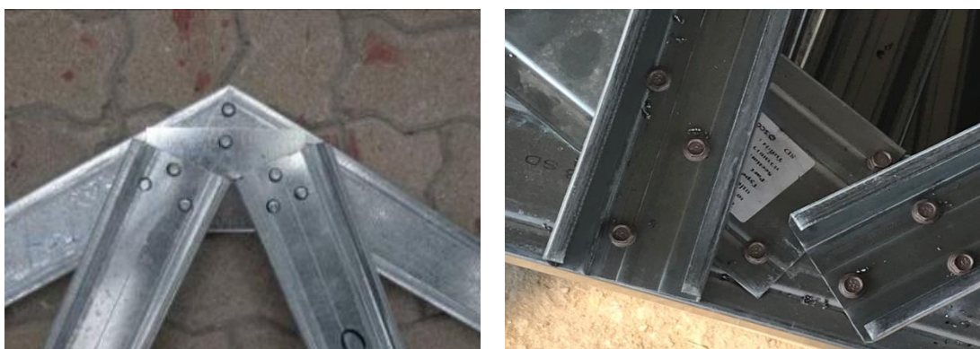
ภาพ 3.27 ใช้ตะปูเกลียว 3 ตัวยึดโครงถักเหล็กชุบกำลวาไนซ์ในแต่ละจุด
