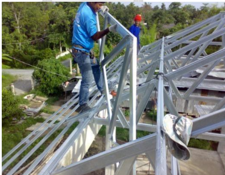
ภาพ 3.29 การติดตั้งโครงถักเหล็กชุบสังกะสี
