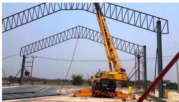
ภาพ 2.5 โครงหลังคาเหล็กรูปพรรณลักษณะโครงถัก
