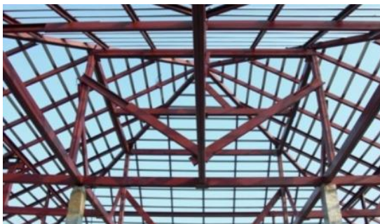
ภาพ 2.4 การเพิ่มค้ำยันโครงหลังคาเหล็กรูปพรรณทรงปั้นหย่า
