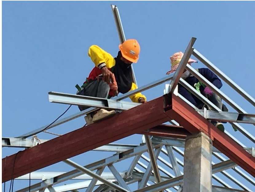
ภาพ 3.32 การติดตั้งแปเหล็กชุบกำลาไนซ์ ที่มา : ถ่ายโดยผู้วิจัย วันที่ 12 มกราคม 2561
