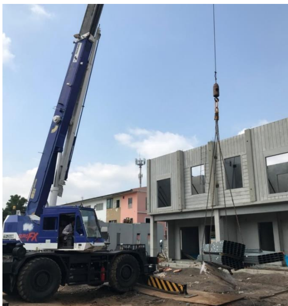
ภาพ 4.15 การขนย้ายชิ้นส่วนเหล็กชูปักลวดไนซ์บริเวณสถานที่ก่อสร้างเพื่อให้เกิดความสะดวกในการทำงานอื่น
