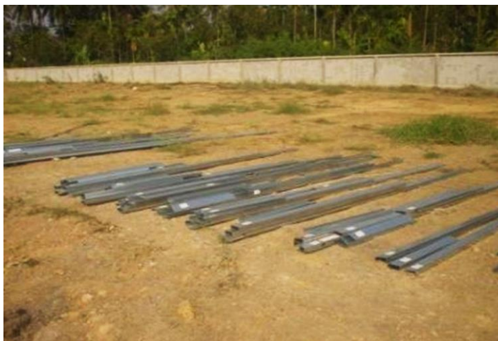
ภาพ 3.26 กลุ่มโครงถักที่จัดกลุ่มแบ่งไว้แต่ละโครงบริเวณพื้นที่ก่อสร้าง
