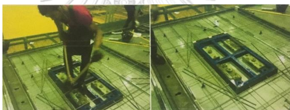
ภาพที่ 62 การตัดเหล็กตะแกรงเสริมออก
