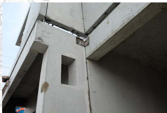
ภาพที่ 46 รอยต่อระหว่าง คาน ผนัง และผนัง
