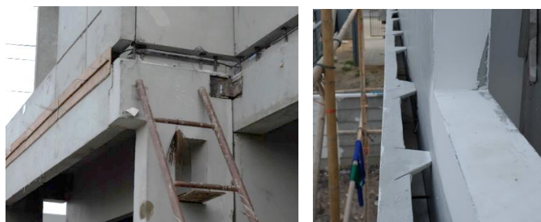
ภาพที่ 65 การปิดทับรอยต่อระหว่างผนังต่างระดับชั้น
