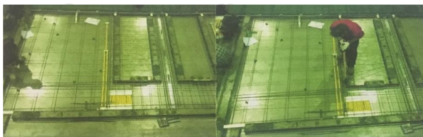
ภาพที่ 43 การตัดเหล็กของตะแกรงเหล็กเสริมส่วนเกินออก
