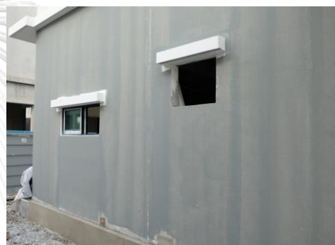
ภาพที่ 50 การปิดทับบบริเวณรอยต่อ
