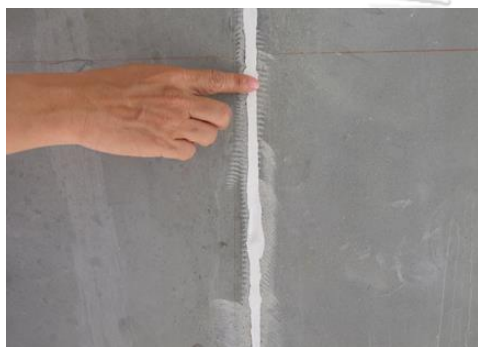
ภาพที่ 49 การปิดรอยต่อด้วยกาว PU
