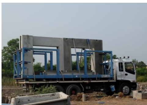
ภาพที่ 29 การขนส่งชิ้นส่วนผนังคอนกรีตสำเร็จรูป
