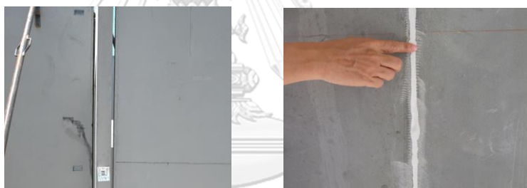
ภาพที่ 64 การปิดทับรอยต่อระหว่างผนังในระดับชั้นเดียวกัน
