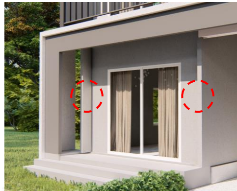
ภาพที่ 68 ตัวอย่างการยื่นครีบบผนังในแนวตั้ง
