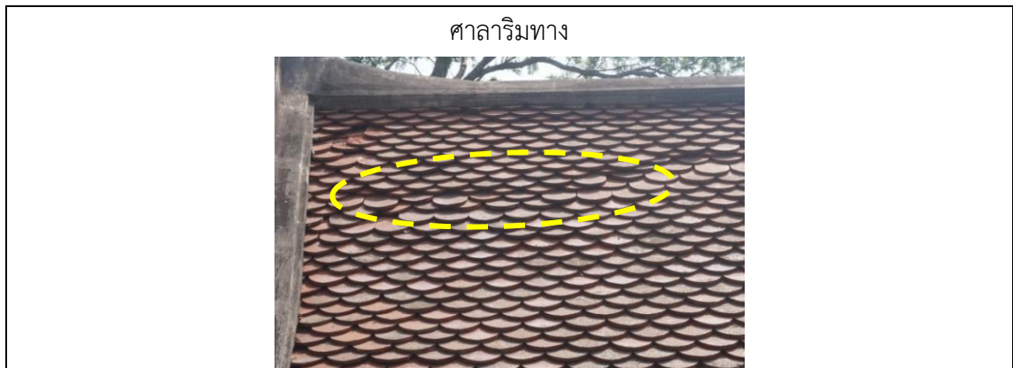
ภาพที่ 123 แสดงตัวอย่างปัญหากระเบื้องหลังคาหลุดเป็นแนวยาวต่อเนื่อง
