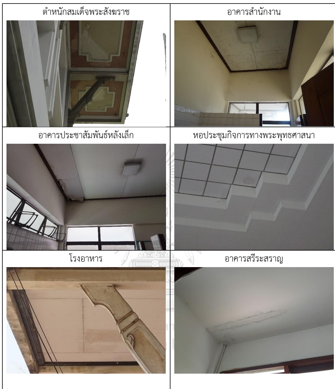
ภาพที่ 129 แสดงตัวอย่างปัญหาฝ้าเพดานมีรอยคราบน้ำแนวตะเข้สัน
