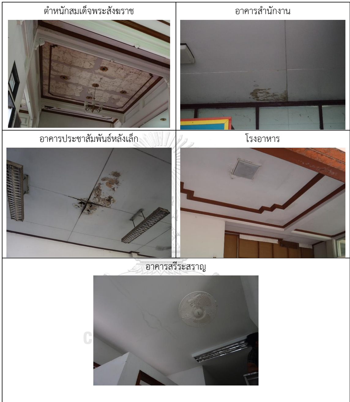
ภาพที่ 128 แสดงตัวอย่างปัญหาฝ้าเพดานมีรอยคราบน้ำแนวสันหลังคา
