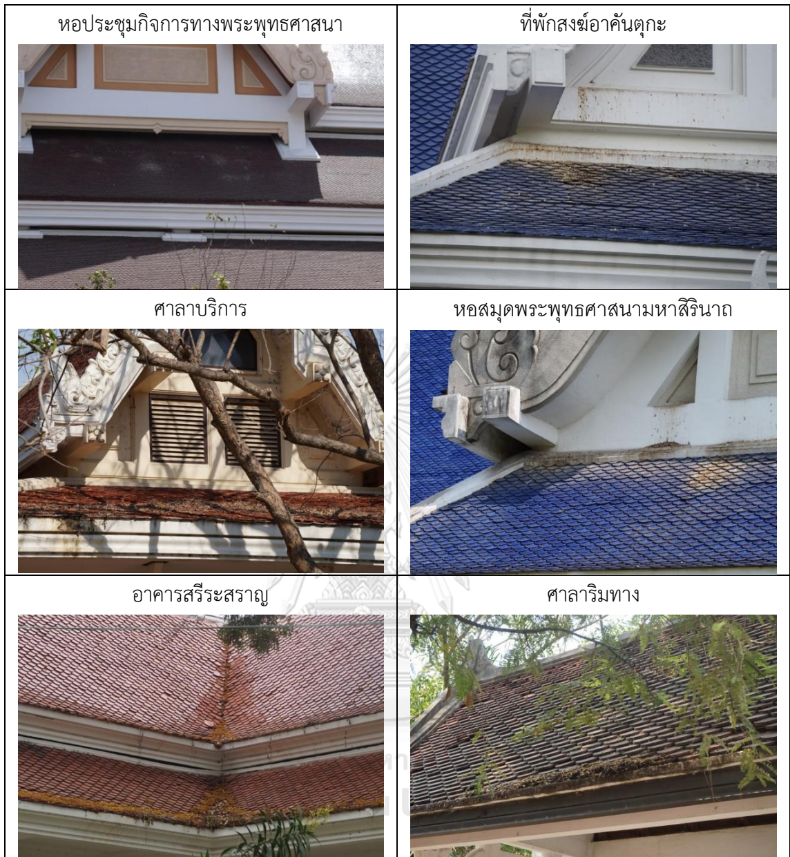
ภาพที่ 126 แสดงตัวอย่างปัญหาไม้เศษฝุ่นหรือใบไม้สะสม
