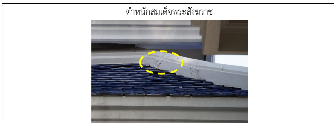
ภาพที่ 115 แสดงตัวอย่างปัญหาจากกรอบตะเข้สันแตก
