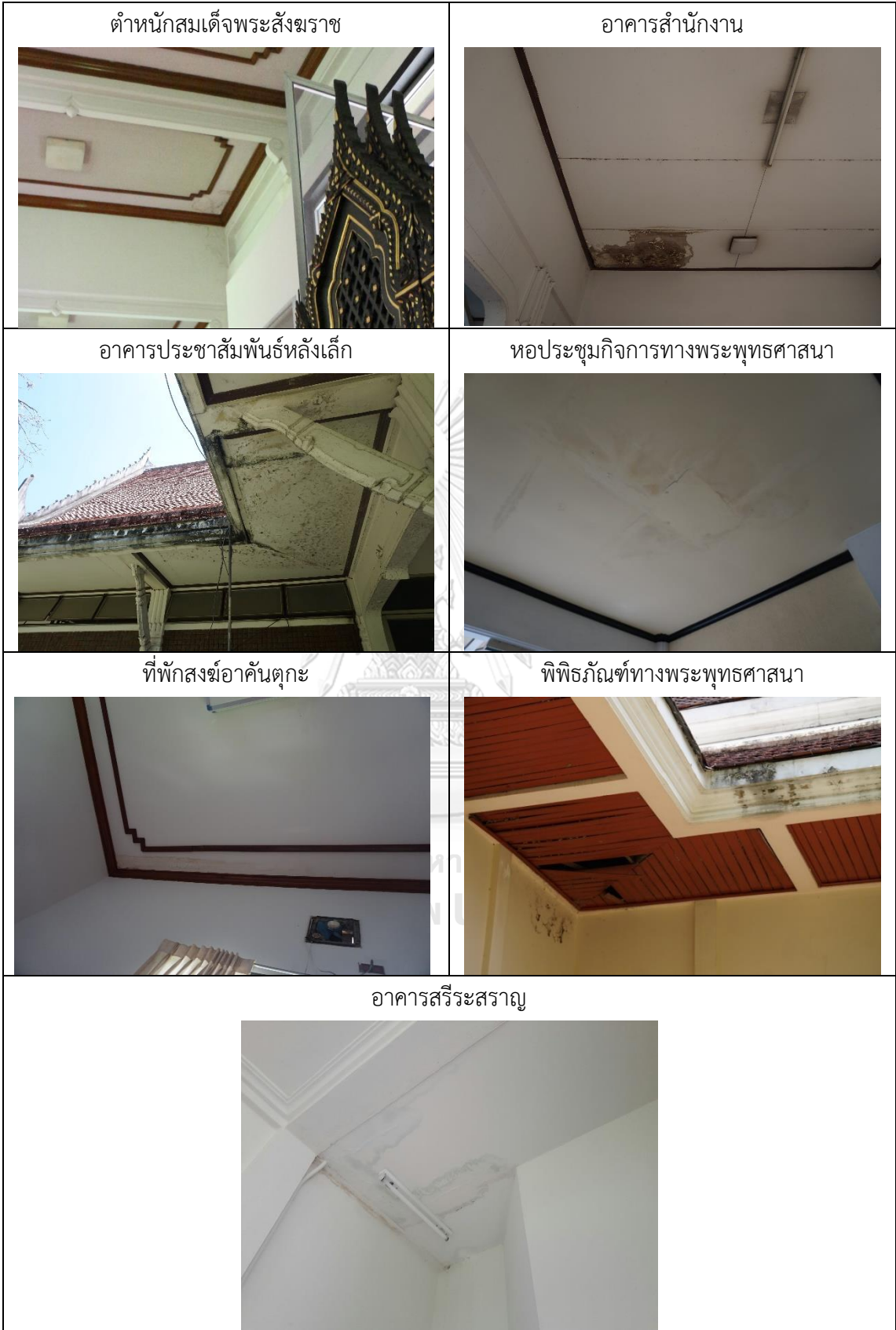
ภาพที่ 130 แสดงตัวอย่างปัญหาฝ้าเพดานมีรอยคราบน้ำแนวตะเข้ราง
