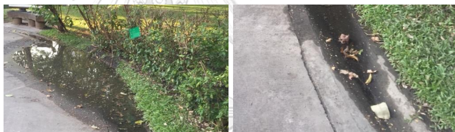
ภาพที่ 29 ทางระบายน้ำอุดตันจากการไหลของดินจากเนินดิน
