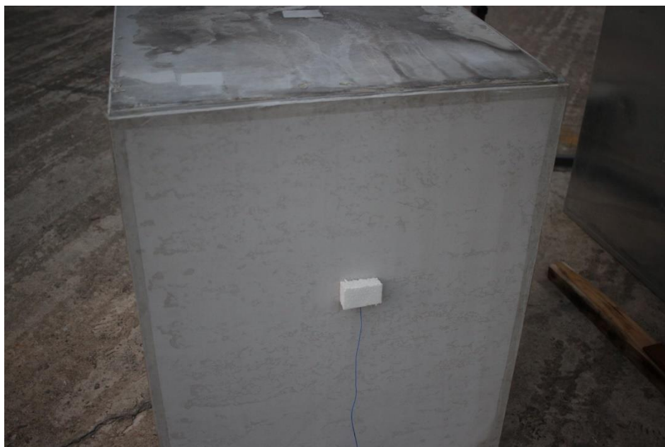
ภาพที่ 3.11 การติดตั้งเซนเซอร์บนผิววัสดุปิดทับด้วยโฟมก้อน
