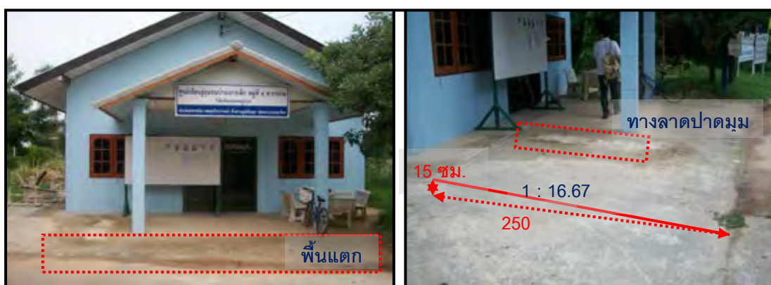
ภาพที่ 5.7 การตรวจประเมินสิ่งอำนวยความสะดวกชุมชนประเภททางลาด ภายในศูนย์การเรียนรู้ชุมชน
