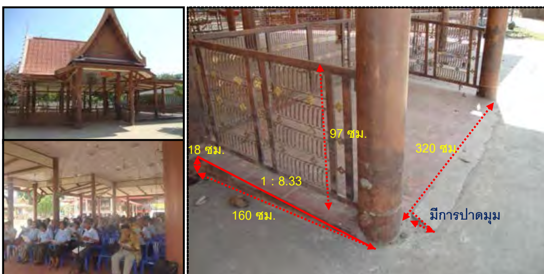
ภาพที่ 5.10 การตรวจประเมินสิ่งอำนวยความสะดวกชุมชนประเภททางลาด ในศาลาเอนกประสงค์ วัดท่าอิฐ
