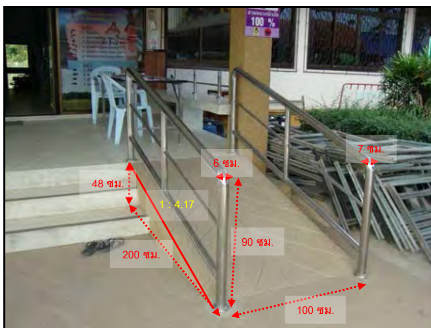
ภาพที่ 5.4 การตรวจประเมินสิ่งอำนวยความสะดวกชุมชนประเภททางลาดภายใน อบต.ท่างาม
