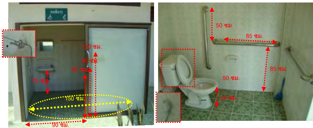
ภาพที่ 5.5 การตรวจประเมินสิ่งอำนวยความสะดวกชุมชนประเภทห้องน้ำ ภายใน อบต.ท่างาม
