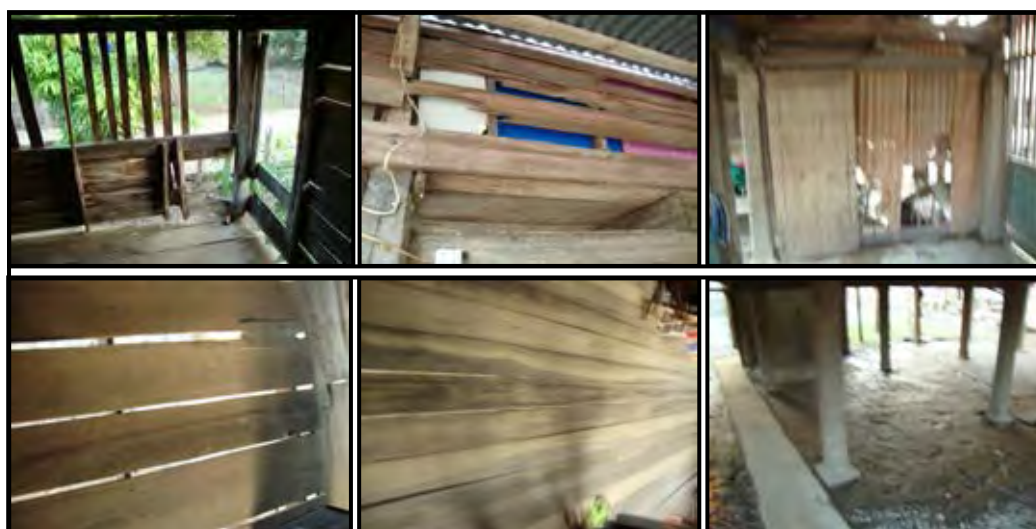
ภาพที่ 5.1 ความเสียหายของบ้านไม้ที่เกิดจากอุทกภัยในปี 2554
