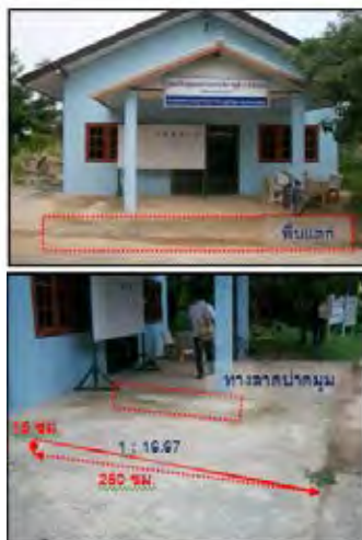
ภาพที่ 6.25 ผลการตรวจติดตามการปรับปรุงพื้นที่ทางลาดด้านหน้าศูนย์การเรียนรู้ชุมชน
