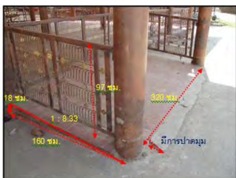
ภาพที่ 6.1 ผลการตรวจติดตามการปรับปรุงพื้นที่ทางลาดด้านหน้าศาลาอเนกประสงค์ วัดท่าอิฐ
