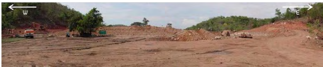
รูปที่ 2.2 แสดงภาพถ่ายมุมกว้างขณะกำลังดำเนินการก่อสร้างเขื่อน
