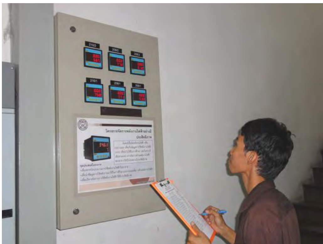
ภาพที่ 3.5 การเก็บข้อมูลปริมาณการใช้พลังงานไฟฟ้า
