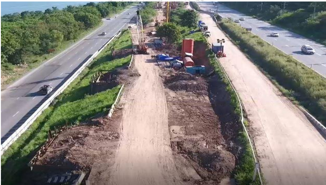
รูปที่ 6.2 การปรับพื้นที่เพื่อให้เครื่องจักรขนาดใหญ่ทำงานได้ในกรณีศึกษา
