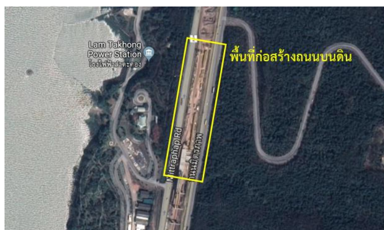
รูปที่ 6.5 พื้นที่ก่อสร้างทางหลวงพิเศษระหว่างเมืองหมายเลข 6 สายบางปะอิน-สระบุรี-นครราชสีมา บริเวณพื้นที่ก่อสร้างถนนวางบนดิน
