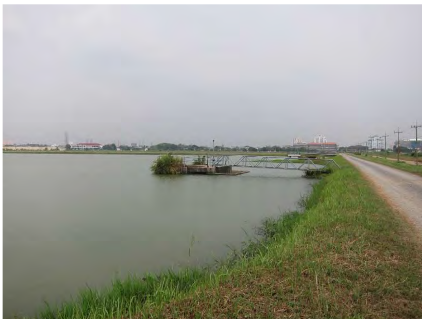
รูปที่ 2.2 บ่อพักตะกอน
