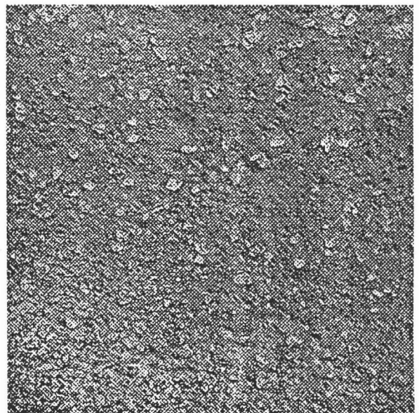
รูป L เป็นภาพพื้นผิวที่มีกลุ่มของหินลอยตัวมาก
