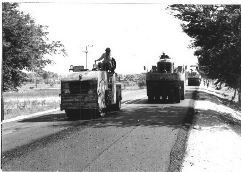
รูปที่ 4.7 เครื่องบดอัดล้อเหล็กและล้อยาง
