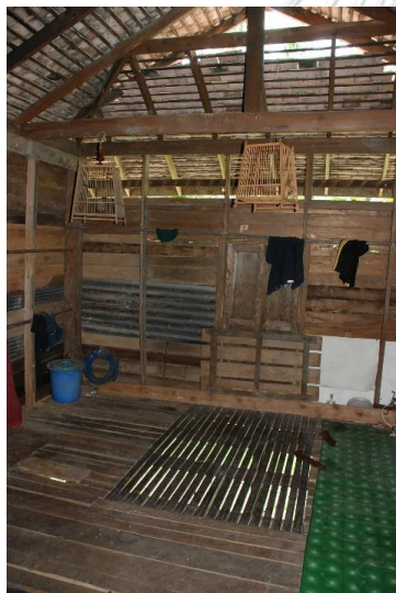
ภาพที่ 3.51 ภายในเรือนพื้นดินชาวพรอนมีพื้นที่พักฟื้นผู้ป่วย ซึ่งจะอยู่ตรงระเบียงเรือน ใช้ไม้หลาโอนที่ทนความชื้นและมีสัมผัสที่เย็นที่นิยมทำแคว่พักผ่อน ตีเว้นร่องเพื่อให้ระบายน้ำได้ดี ในเวลาที่ต้องดูแลผู้ป่วยติดเตียงในกรณีที่มีคนป่วย ซึ่งจะมีญาติพี่น้อง คนรู้จักแวะเวียนมาเยี่ยมและนอนค้างคืนอยู่เสมอ เนื่องจากในสมัยก่อนที่การเดินทางไม่สะดวกสบายเช่นเดียวกันกับในปัจจุบัน
