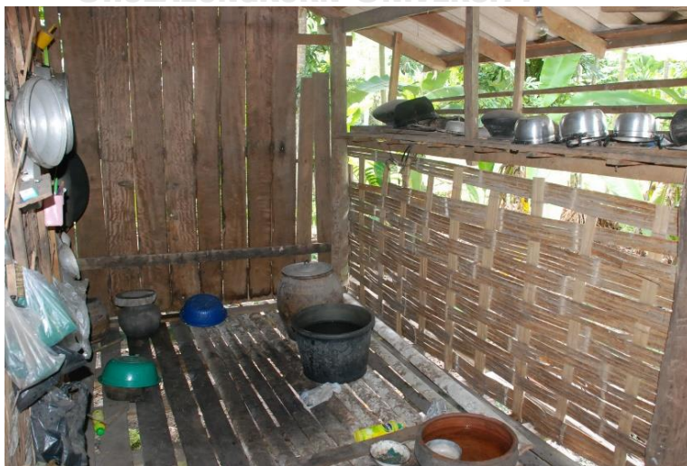
ภาพที่ 4.99 แสดงการยื่นโครงสร้างทำที่เก็บของในผนัง
