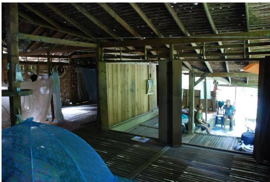
ภาพที่ 4.101 ลักษณะการเปิดประตูบานเพี้ยมกว้าง สร้างพื้นที่กึ่งภายในภายนอก
