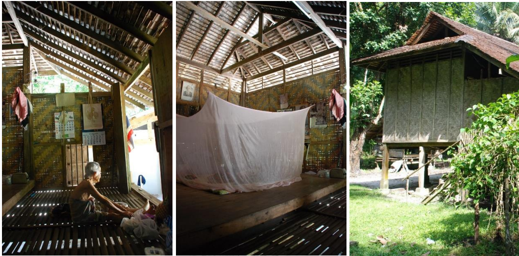
ภาพที่ 4.69 เรือนชาวพว่อนมีหลังคาลาดชัน และไม่ทำฝ้าเพดาน นิยมใช้พื้นไม้กระดานเว้นร่อง ผนังไม้ไผ่สาน ช่องเปิดที่เหมาะสมพอดีพอดี และช่องลม เพื่อการระบายความชื้นและอากาศร้อน
