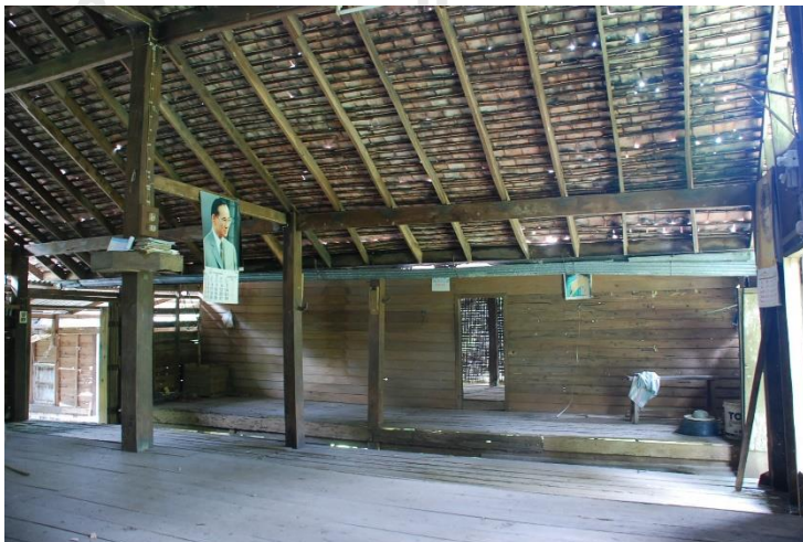
ภาพที่ 4.39 เรือนข้าวมีผนังกันมิดชิดตลอดแนว
