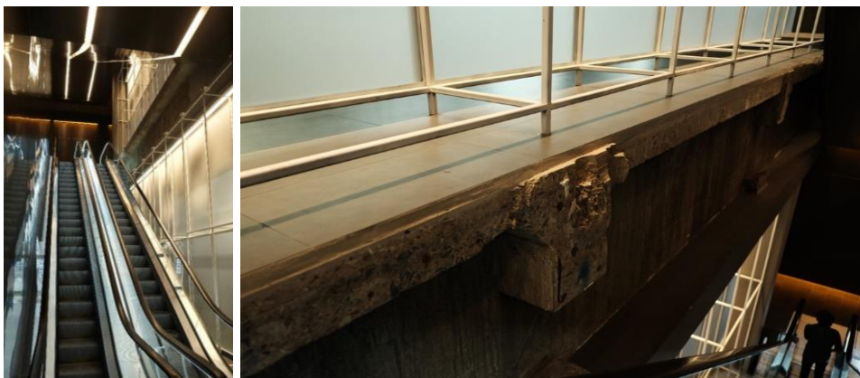
ภาพที่ 46 พื้นที่ภายในส่วนที่ได้รับการเจาะพื้นอาคารเพื่อเชื่อมต่อพื้นที่ในแต่ละชั้นของโครงการ ที่มา: ผู้วิจัย
