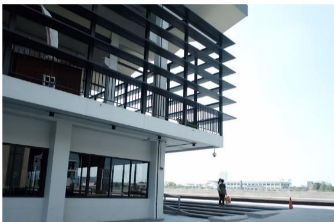
ภาพที่ 68 การติดตั้งแผงอะลูมิเนียม และแผงกันแดดที่มาจากแนวทางการอนุรักษ์พลังงาน ที่มา: ผู้วิจัย
