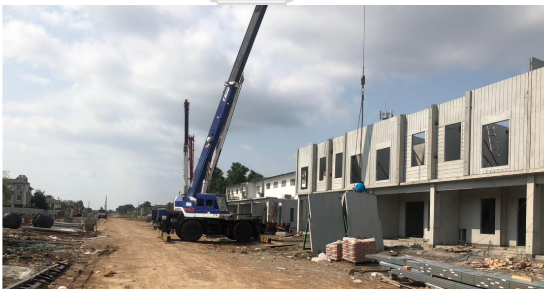
ภาพที่ 32 การติดตั้งชิ้นส่วนคอนกรีตสำเร็จรูป
