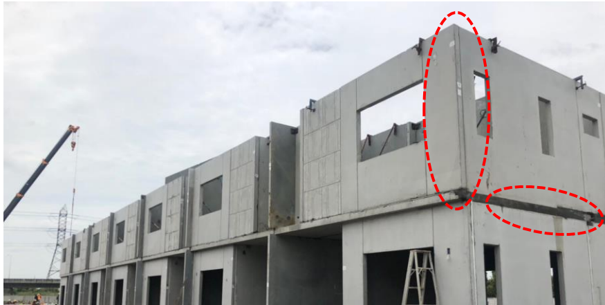
ภาพที่ 44 การใช้ปูนซีเมนต์ไม่หดตัวบริเวณรอยต่อผนังภายนอก
