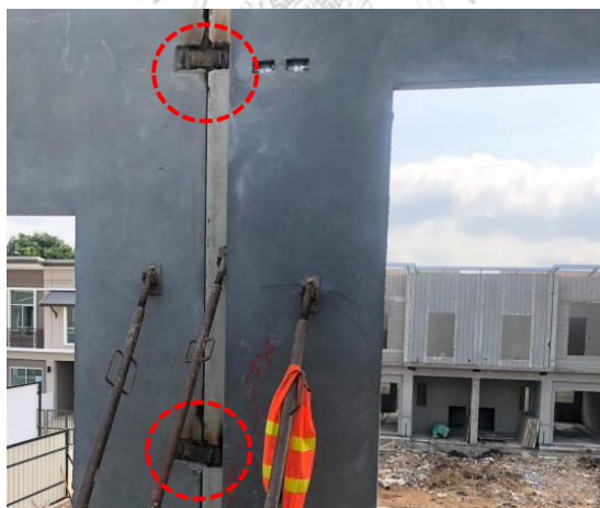
ภาพที่ 43 การใช้เพลทเหล็กบริเวณรอยต่อระหว่างผนังภายใน
