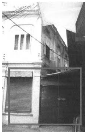
ภาพที่ 173 ปัญหาทางสถาปัตยกรรมที่เกิดจากการต่อเติมพื้นที่ใช้สอย
