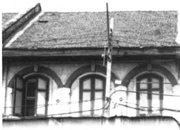
ภาพที่ 171 ปัญหาทางสถาปัตยกรรมที่เกิดจากการชำรุดของส่วนประกอบของตึกแถวริมถนนเจริญกรุง ดังเช่น หลังคาไม้และวัสดุผนังที่เป็นกระเบื้องดินเผา และกันสาดสังกะสี
