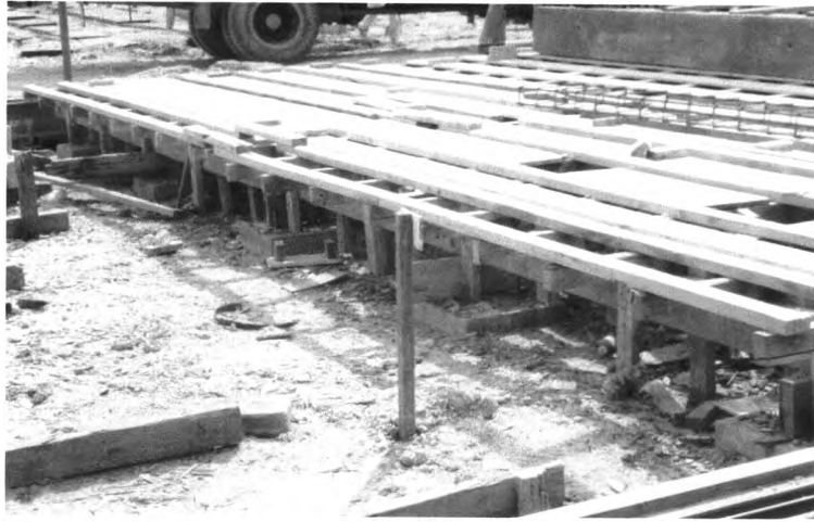
ภาพที่ 5-9 ลักษณะแพงานโรงงานส่วนผลิตชิ้นส่วนคานสำเร็จ
