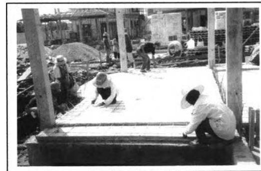
ภาพที่ 5-119 งานพื้นชั้นล่าง
