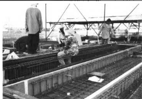
ภาพที่ 5-139 ชิ้นส่วนแต่ละชิ้นมีโครงสร้างเหล็กแยกกันเป็นอิสระ
