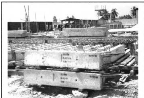
ภาพที่ 5-86 คานคอดินสำเร็จรูป
