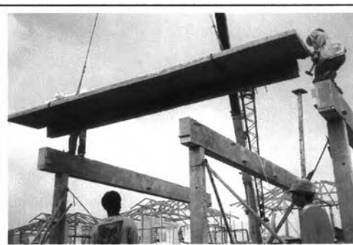
ภาพที่ 5-111 การติดตั้งคานที่มีพื้นยื่น
