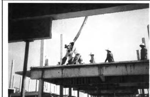
ภาพที่ 5 -123 งานเทคอนกรีตชั้นสอง
