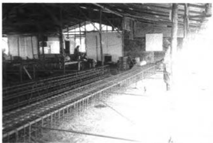
ภาพที่ 5- 74 ประกอบโครงเหล็ก
