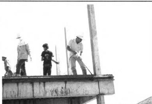
ภาพที่ 5 -124 ใช้เครื่องจี้คอนกรีต
