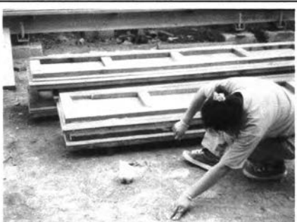
ภาพที่ 5- 76 ทาสีน้ำมันข้างไม้แบบ
