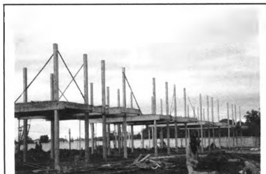
ภาพที่ 5-118 ติดตั้งเสาชั้นสอง
