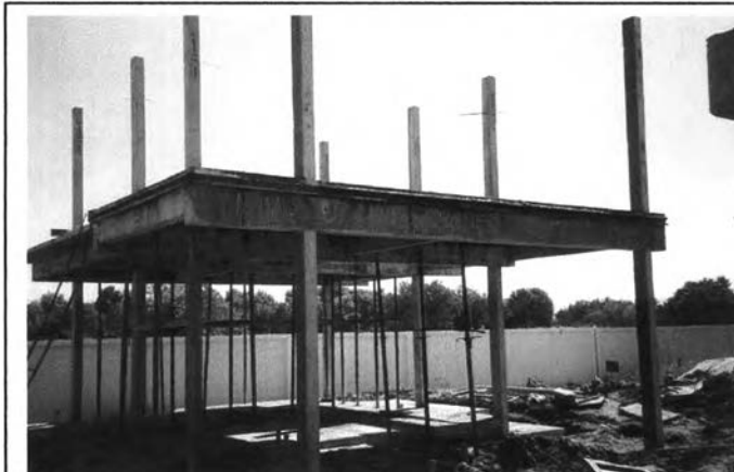
ภาพที่ 5 -126 งานโครงสร้างแล้วเสร็จ
