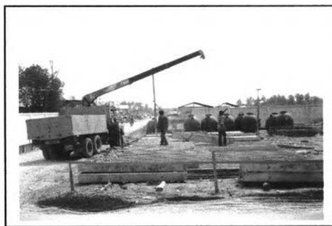
ภาพที่ 5-71 ขนย้ายชิ้นส่วนไปทำการติดตั้ง
