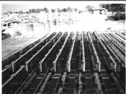
ภาพที่ 5- 78 วางโครงเหล็กบนพื้นแบบ
