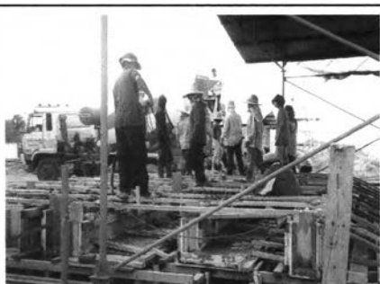
ภาพที่ 5- 80 เทคอนกรีตเพื่อหล่อชิ้นงาน
