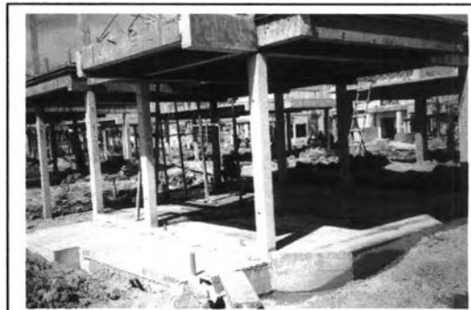
ภาพที่ 5 -125 งานเทคอนกรีตแล้วเสร็จ
