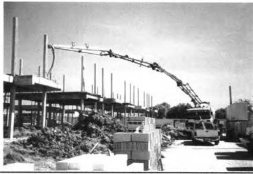
ภาพที่ 5 -120 เทคอนกรีตโดยใช้รถปั๊ม
