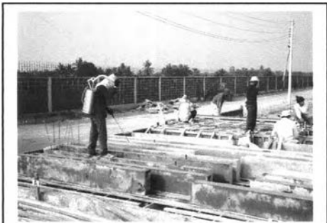
ภาพที่ 5-82 ถอดแบบพ่นน้ำยาบ่มคอนกรีต
