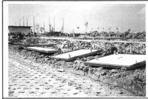
ภาพที่ 5-113 แผ่นพื้นห้องน้ำ,ระเบียงสำเร็จรูป
