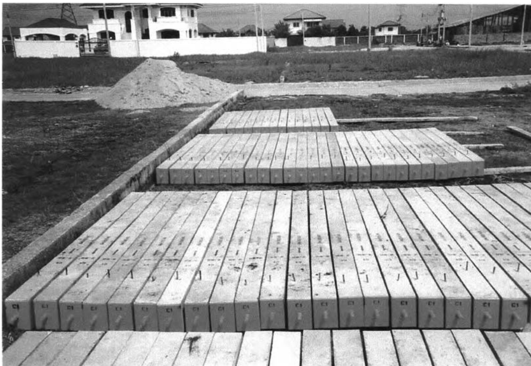
ภาพที่ 5 - 17 เสาคอนกรีตหล่อสำเร็จรูปด้านมีเดือย
