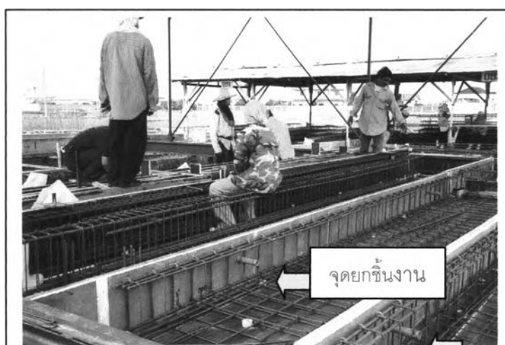
ภาพที่ 5 - 69 จุดยกชิ้นงาน (Lift Point)
