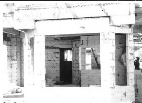
ภาพที่ 5 - 128 งานก่ออิฐ
