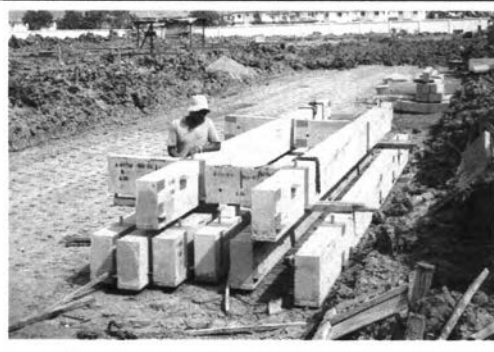
ภาพที่ 5-105 กองชิ้นส่วนสำเร็จรูปรอการติดตั้ง
