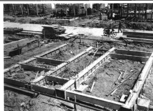
ภาพที่ 5-102 คานคอดินหลังแกะแบบ
