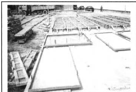
ภาพที่ 5-88 แผ่นพื้นระเบียงหล่อสำเร็จรูป
