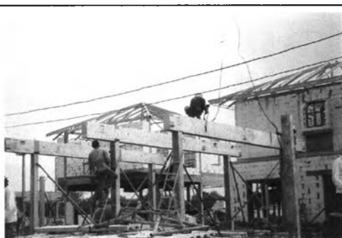
ภาพที่ 5-110 การประกอบชิ้นส่วนคานเมนชั้น2
