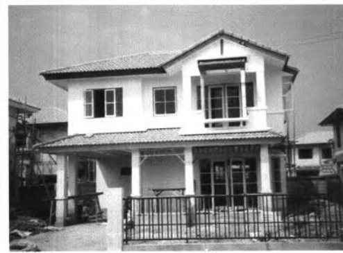
ภาพที่ 5 - 132งานก่อสร้างแล้วเสร็จร้อยละ 90
