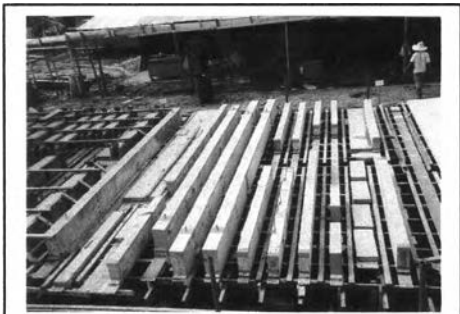
ภาพที่ 5-84 ทาสีกันสนิมที่เพลทเหล็ก
