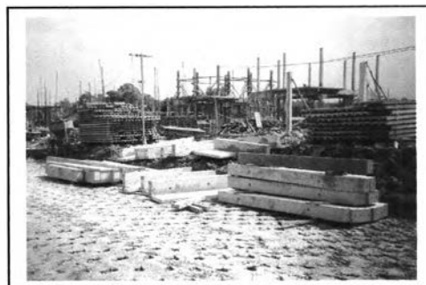
ภาพที่ 5-73 ชิ้นส่วนสำเร็จรูปรอการติดตั้ง
