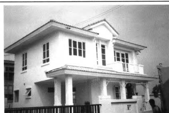
ภาพที่ 5 - 133 งานก่อสร้างแล้วเสร็จร้อยละ 95
