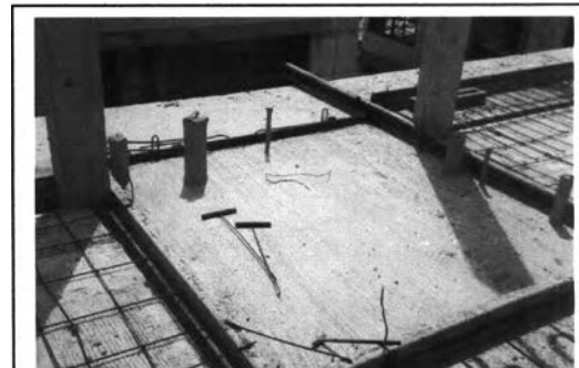
ภาพที่ 5-117 แผ่นพื้นห้องน้ำสำเร็จรูปติดตั้งสำเร็จ
