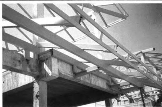
ภาพที่ 5 - 129 งานโครงหลังคาชั้นล่าง
