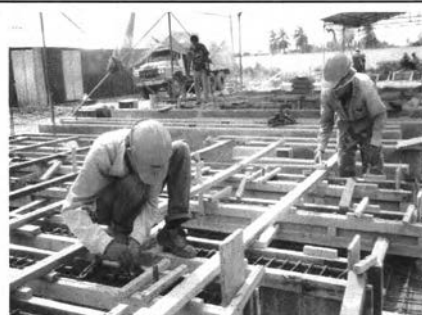
ภาพที่ 5- 79 ประกอบไม้แบบ
