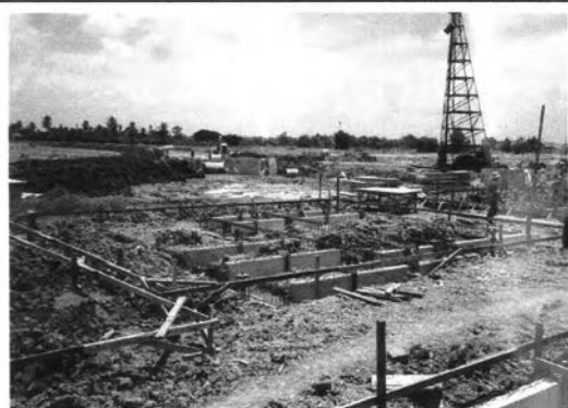
ภาพที่ 5-98 นำคานคอดิน(ชอย)สำเร็จประกอบติดตั้ง
