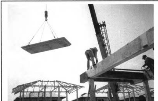
ภาพที่ 5-114 การยกแผ่นพื้นระเบียงสำเร็จรูป
