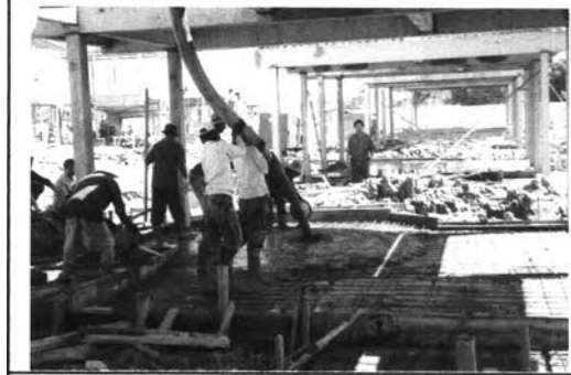
ภาพที่ 5 -121 เทคอนกรีตพื้นชั้นล่าง
