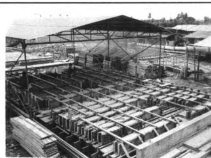
ภาพที่ 5 - 81 รอคอนกรีตให้ได้อายุ
