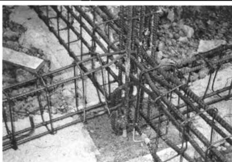
ภาพที่ 5- 138 การบีบเหล็กเพื่อการเข้าแบบสำหรับโครงสร้างที่ตัดผ่านกัน
