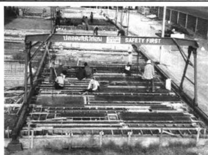
ภาพที่ 5- 77 ทาน้ำมันเคลือบไม้แบบ
