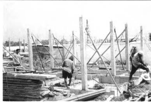
ภาพที่ 5-107 ติดตั้งเสาชั้นล่างพร้อมค้ำยันตั้ง
