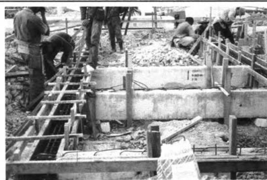
ภาพที่ 5- 100 ประกอบไม้แบบคานคอดินเมน
