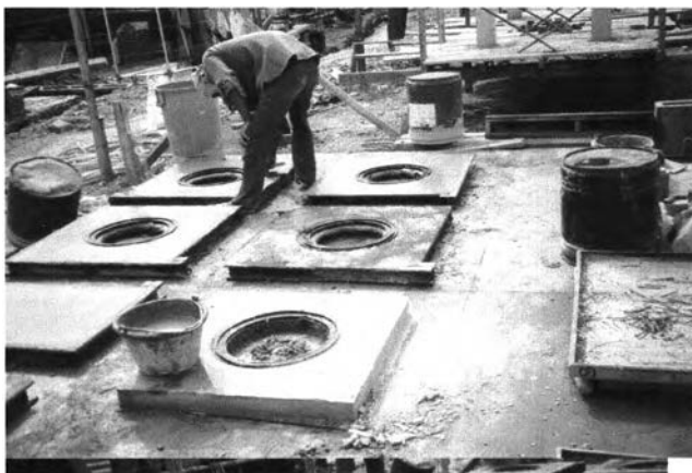
ภาพที่ 5 - 94 หล่อฝาท่อถังบำบัดหล่อสำเร็จรูปจากเศษปูนที่เหลือ
