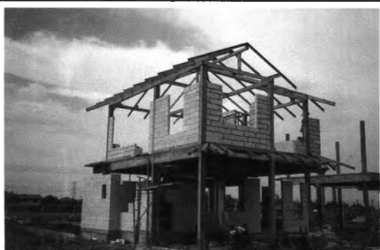
ภาพที่ 5 - 127 งานโครงหลังคา
