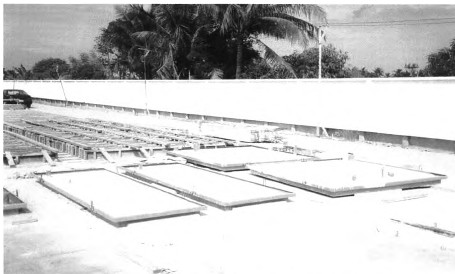
ภาพที่ 5 - 12 พื้นที่ส่วนผลิตแผ่นพื้นห้องน้ำสำเร็จรูปและแผ่นพื้นระเบียงสำเร็จ
