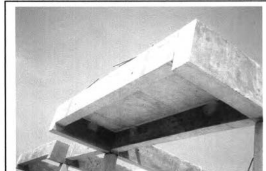
ภาพที่ 5-115 ติดตั้งแผ่นพื้น ระเบียงสำเร็จรูป
