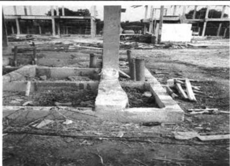
ภาพที่ 5- 136 การเข้าแบบไม่ได้มาตรฐานพบงานที่ผิดพลาดหลังจากแกะแบบ
