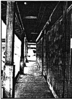
เรือนแถวไม้ที่มีช่องทางเดินด้านหน้าเพื่อประโยชน์ด้านการค้า และเสาดอาคารรองรับด้วยปูนซีเมนต์ตามรูปแบบภูมิปัญญาในอดีต
