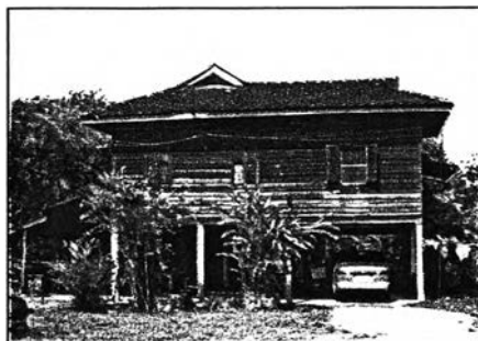
บ้านเดี่ยว 2 ชั้นได้ทุนสูง หลังคามนิลา สร้างในพื้นที่สวน ได้รับอิทธิพลจากภูมิปัญญา ห้องถื่นในการป้องกันน้ำท่วม และมีพื้นที่ด้านล่างไว้เก็บผลผลิตทางการเกษตร
