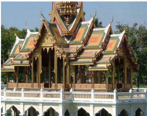
ภาพที่ 3.1.7.4 หลังคาของอาคารชั้น 4 ชั้น 3 ตับ ตัวอาคารจำลองแบบมาจากพระที่นั่งอภรณ์พิโมกษ์ปราสาท ในพระบรมมหาราชวัง
