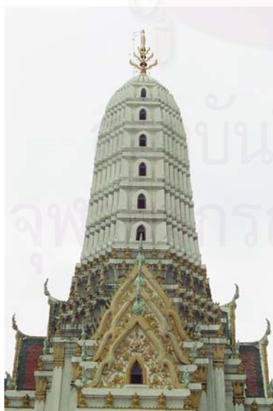
ภาพที่ 4.3.1.4 ยอดปรางค์ของพระปรางค์องค์ประธาน ตรงชั้นบันแถลงเจาะเป็นช่องระบายอากาศ
