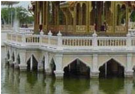
ภาพที่ 3.1.7.2 ส่วนฐานของอาคารที่ตั้งอยู่กลางน้ำ เปลี่ยนเป็นโครงสร้างคอนกรีตเสริมเหล็กสมัยรัชกาลที่ 6
