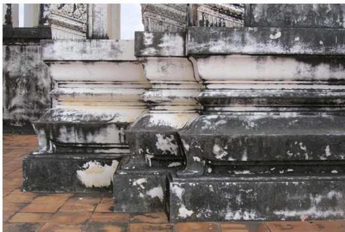
ภาพที่ 3.2.1.2 ฐานของอาคารเป็นฐานสิงห์บัวลูกแก้วอกไก่ ก่ออิฐถือปูนทาสีขาว
