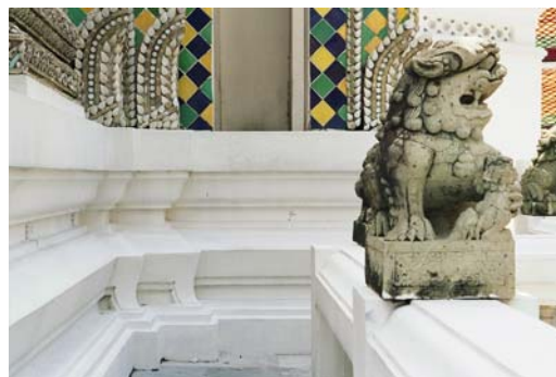
ภาพที่ 4.3.3.3 ฐานชั้นบน เป็นฐานสิงห์ก่ออิฐถือปูนทาสีขาว
