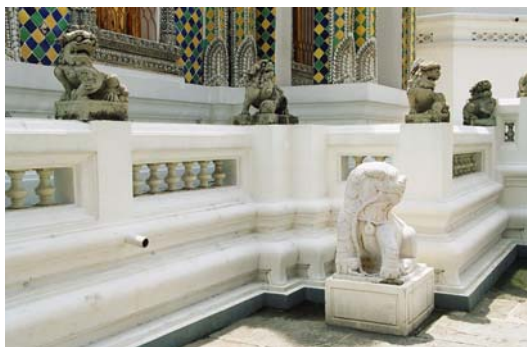
ภาพที่ 4.3.3.2 ฐานไฟที เป็นฐานสิงห์ก่ออิฐถือปูนทาสีขาว
