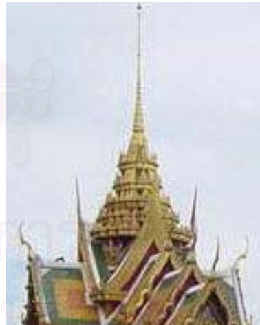
ภาพที่ 3.1.7.5 ยอดทรงมณฑป ทำเป็น 5 ชั้น แบบปราสาท หลังคาชั้นบนสุด ทำเป็นแบบบันลม เรียกว่าพระวิมานมีความพิเศษกว่าที่อื่น
