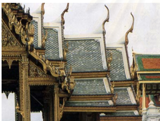
ภาพที่ 5.21 หลังคาของพระที่นั่งอาภรณ์พิโมกข์ปราสาท มุงด้วยแผ่นกระเบื้องดินบุก
