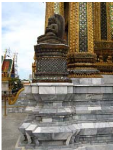
ภาพที่ 4.1.1.4ฐานชั้นล่างของพระมณฑป เป็นฐานสิงห์บัวลูกแก้วอกไก่ ประดับด้วยหินอ่อน
