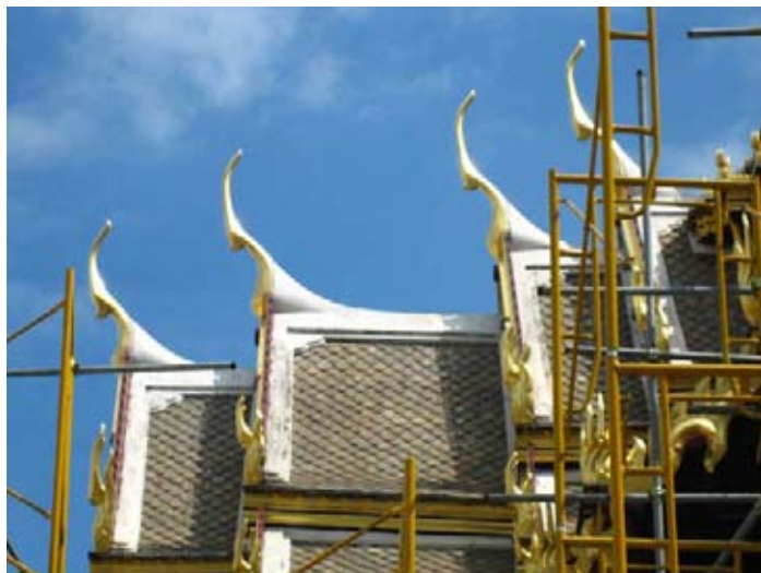
ภาพที่ 3.1.4.3 การซ้อนชั้นของหลังคา 4 ชั้น 3 ตับ
