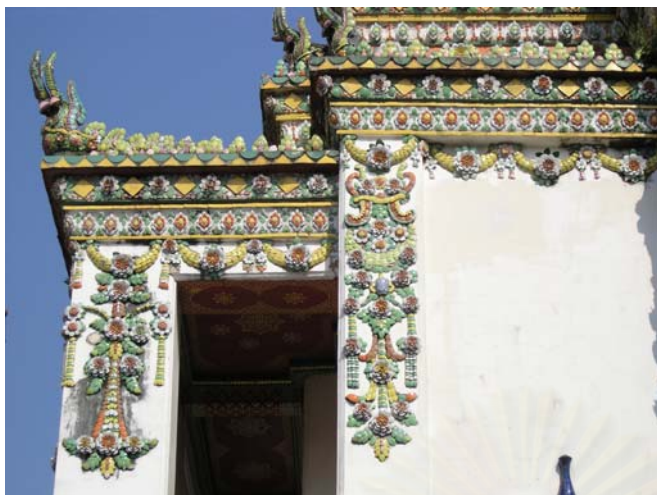
ภาพที่ 4.2.2.6 การตกแต่งด้วยกระเบื้องเคลือบตามแนวเสา
