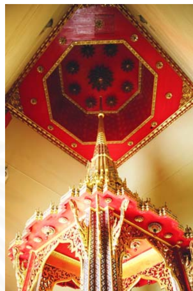
ภาพที่ 4.3.4.9 ฝ้าเพดานด้านในอาคารประดับด้วยดาวเพดานไม้แกะสลักปิดทองประดับกระจกสี
