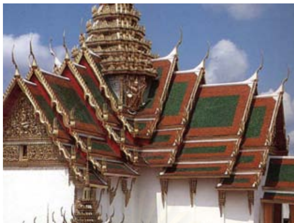
ภาพที่ 5.8 การซ้อนชั้นหลังคาของพระที่นั่งดุสิตมหาปราสาท
