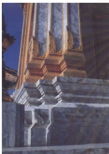
ภาพที่ 4.2.3.4 บริเวณมุมที่ย่อมุมไม้สิบสอง และประดับโมเสคสีทองตามแนวโครงสร้าง
