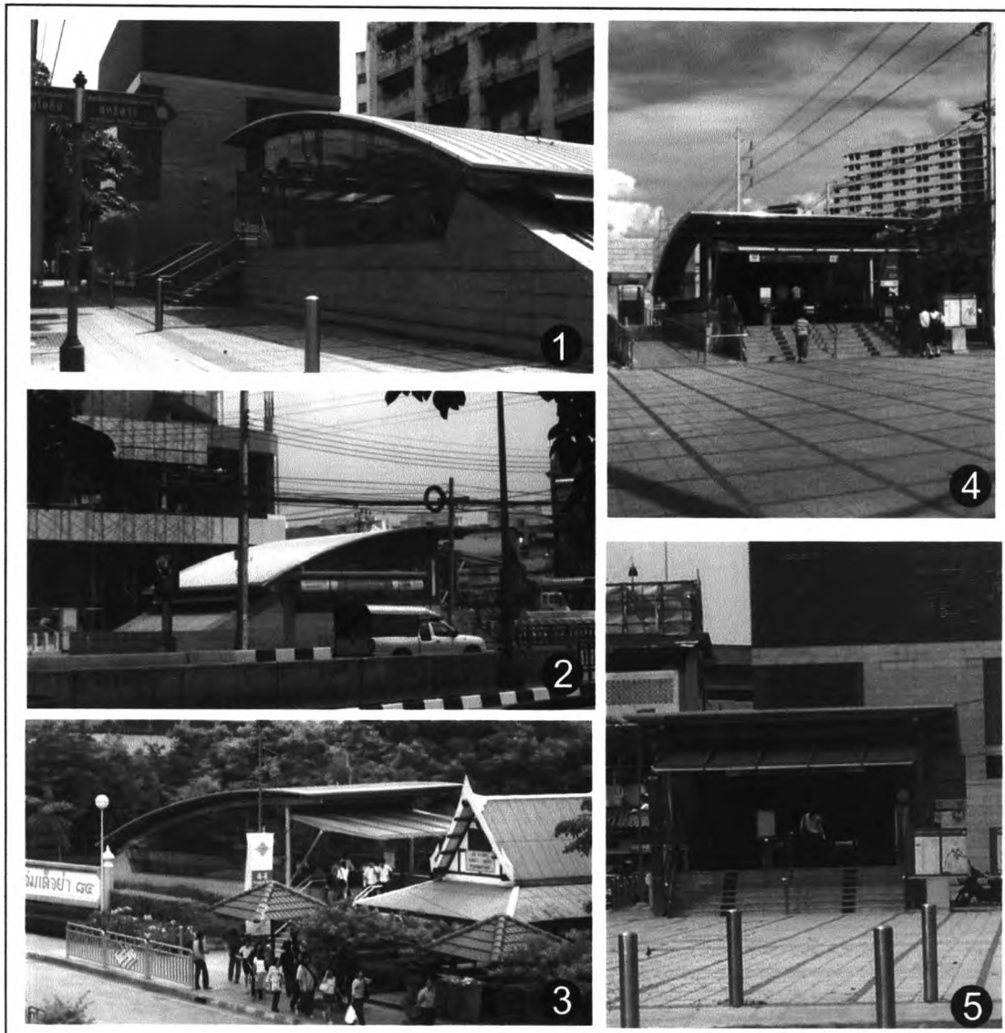
รูปที่ 3.13 จุดขึ้นลง (ประตู) สถานีรถไฟฟ้าใต้ดินพหลโยธิน
