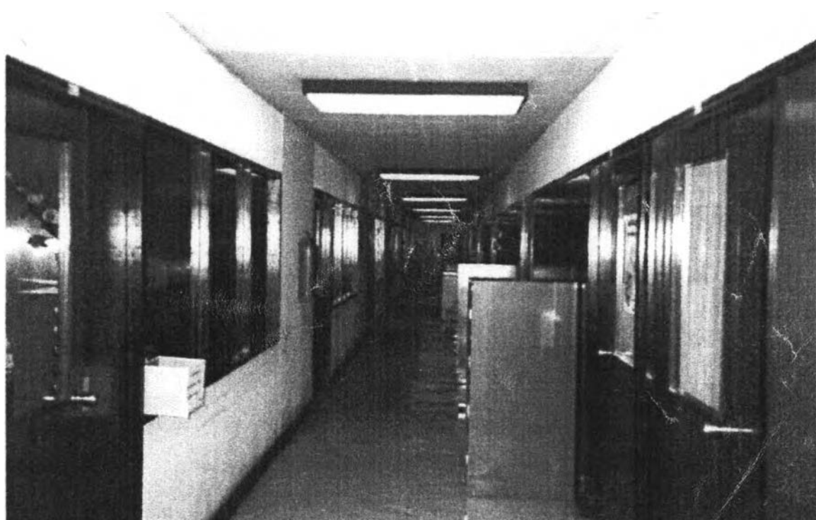
ทางเดินภายในอาคาร 4 ชั้น
