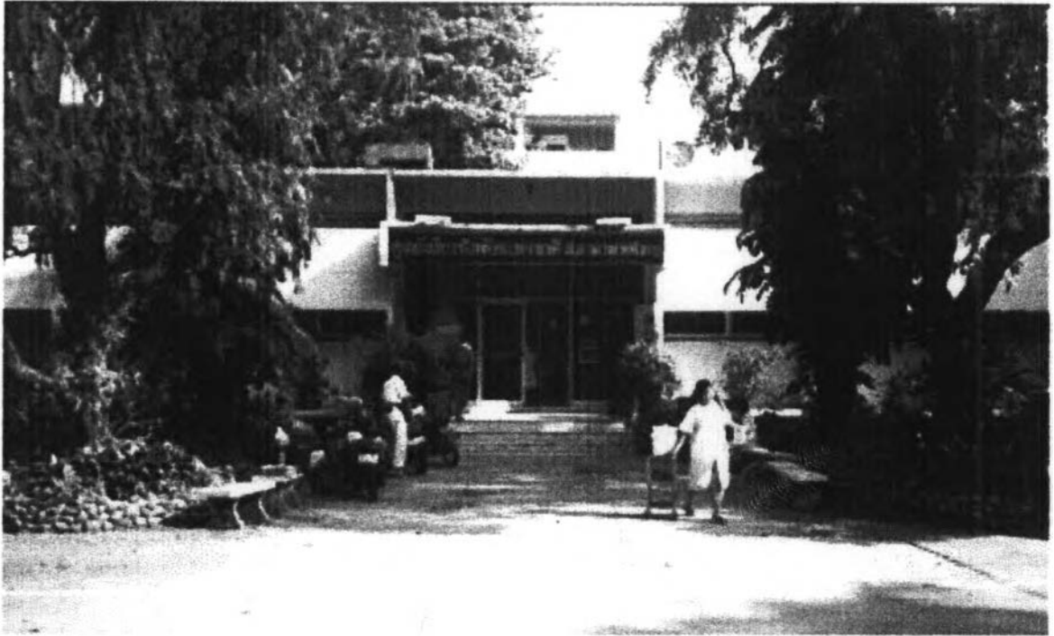
อาคารชั้นเดียว (อาคารรับบริจาคโลหิต)
