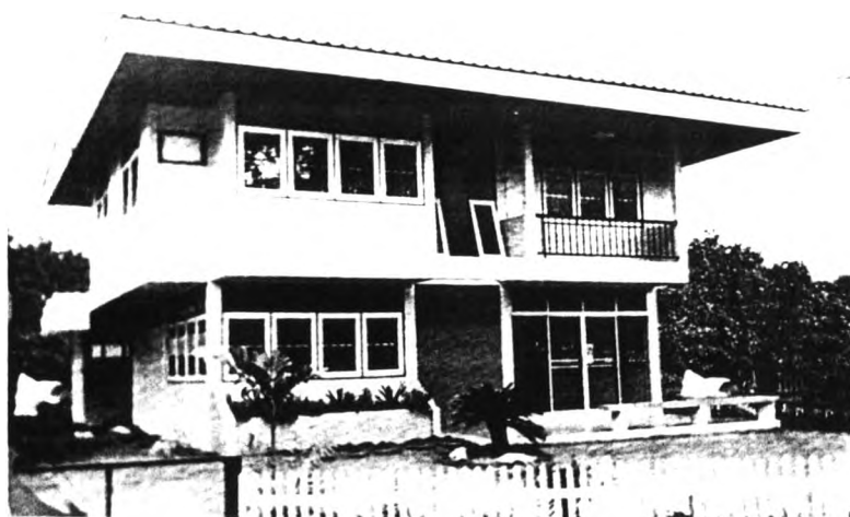
ภาพที่ 2 -11 บ้านกึ่งสำเร็จรูประบบเสาคาน ของ ซีคอน หลังแรก เมื่อปี พ.ศ. 2510
