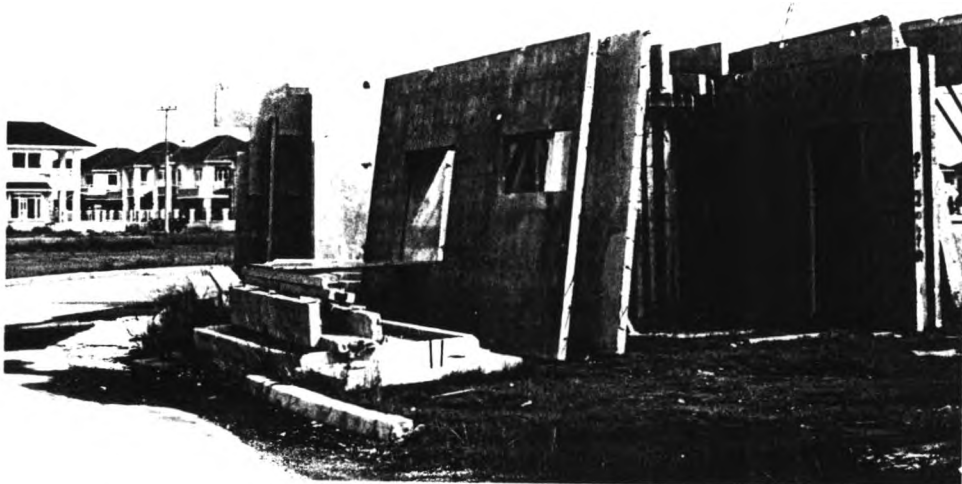
ภาพที่ 2 -14 ชั้นส่วนผนังคอนกรีตสำเร็จรูป สำหรับบ้านระบบผนังรับน้ำหนัก
