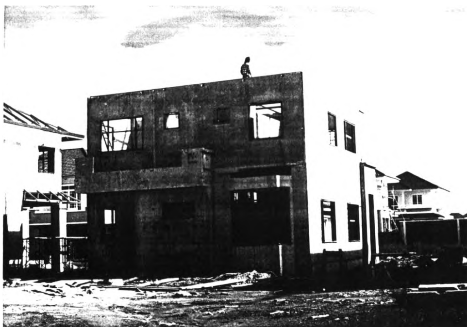
ภาพที่ 2 - 15 บ้านกิ่งสำเร็จรูประบบผนังรับน้ำหนัก ขณะติดตั้งโครงสร้างคอนกรีตสำเร็จรูป แล้วเสร็จ
