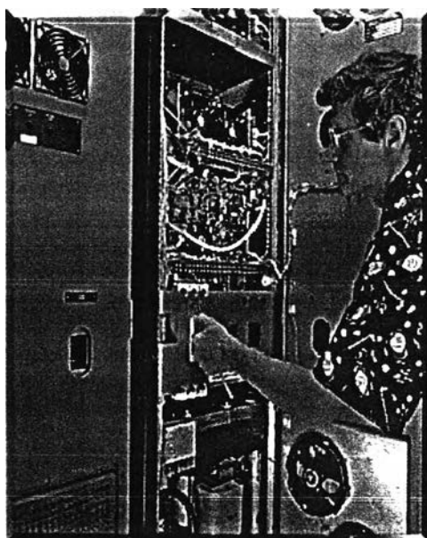
รูปที่ 2.8 เครื่องปรับกระแสไฟฟ้าที่ได้รับจากระบบเซลล์แสงอาทิตย์เพื่อการใช้งาน
