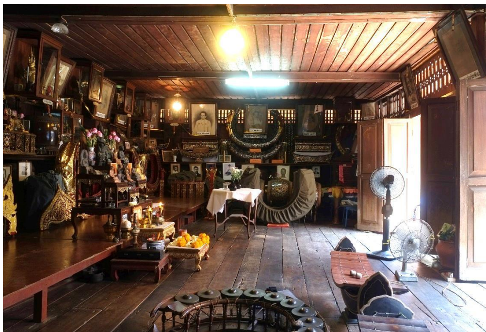
ภาพที่ 12 ห้องเก็บเครื่องและสถานที่ใช้ต่อเพลงของบ้านพาทย์โกศล ก่อนการซ่อมแซม ที่มาภาพ : รองศาสตราจารย์สุรพล สุวรรณ
