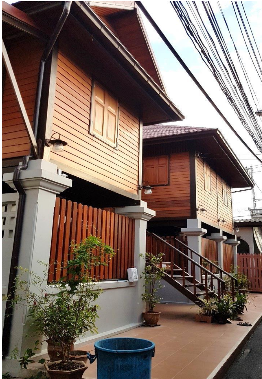
ภาพที่ 13 บ้านพาทย์โกศล (บ้านเครื่อง) ปัจจุบัน หลังการปรับปรุงซ่อมแซมใหม่ ที่มาภาพ : พิระพล ปลิวมา บันทึกภาพเมื่อวันที่ 31 ตุลาคม 2562
