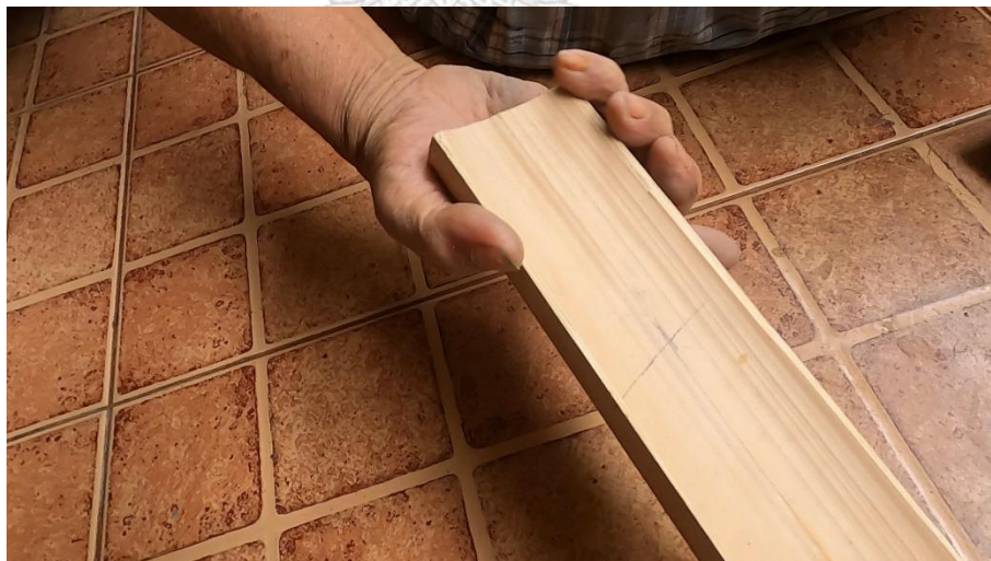
ภาพที่ 98 การหาจุดกลางลูกกระขนาดท่อมและใช้ดินสอทำสัญลักษณ์ ที่มา: ปรีทัศน์ เรืองยิ้ม วันที่ 15 มิถุนายน 2563
