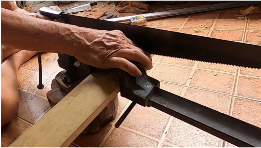
ภาพที่ 94 การใช้เลื่อยตัดให้ได้ความยาวตามเส้นที่ได้ขีดไว้ ที่มา: ปรีทัศน์ เรืองยิ้ม วันที่ 15 มิถุนายน 2563
