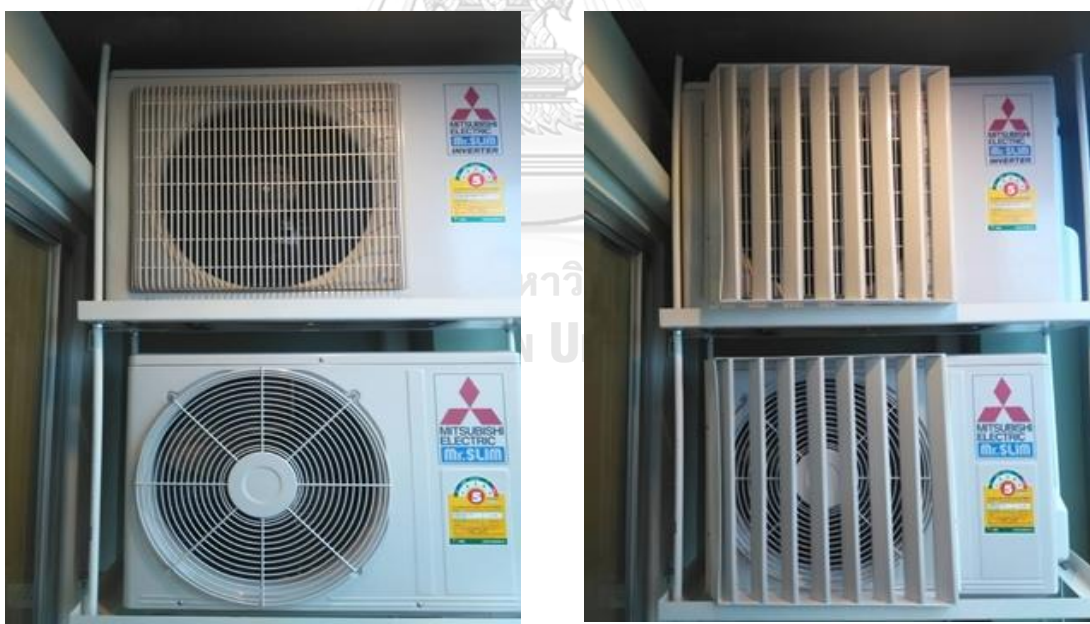
ภาพที่ 46 การติดตั้งคอมเพรสเซอร์แอร์แบบเป่าออกด้านข้าง
