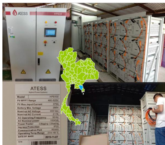
รูปที่ 2-12 ตัวอย่างไฮบริดส์อินเวอร์เตอร์ Ateess ขนาด 30 kW
