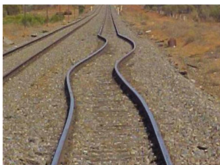
รูปที่ 7 การโค้งงอของรางรถไฟเพราะการขาดการจำกัดขอบเขตด้านข้าง (Indraratna et al., 2011)
