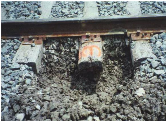
รูปที่ 2 การเกิดตะกรันของหินโรยทาง (Indraratna et al., 2011)
