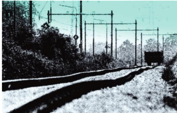
รูปที่ 4 รูปทรงที่ต่างไปจากเดิมบนรางรถไฟที่มีสาเหตุมาจากการเสีรูปร่างของหินโรยทาง (Indraratna et al., 2011)
