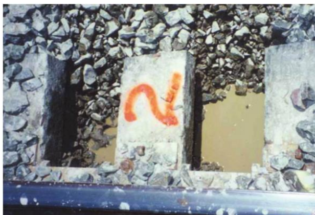
รูปที่ 3 การซังของน้ำในชั้นหินโรยทาง (Indraratna et al., 2011)
