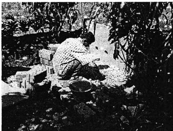
ภาพที่ 4.37 แสดงการเตรียมปรับระดับพื้นในการก่อสร้างแบบจำลองเพื่อใช้ในการวิจัย
