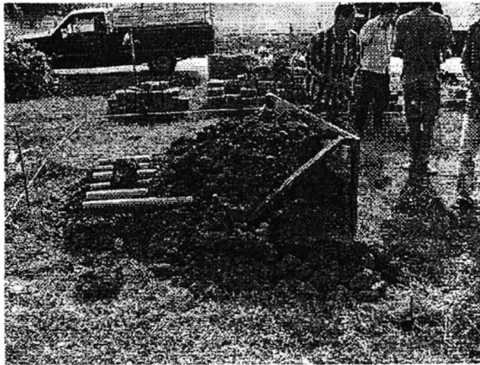
ภาพที่ 4.30 แสดงการก่อสร้างแบบจำลองเพื่อใช้ในการวิจัย
