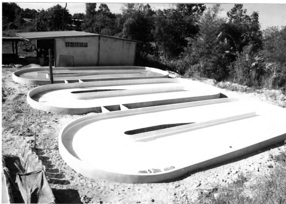
ภาพที่ 12 รูปภาพแสดงลักษณะบ่อ raceway รูปวงรี ขนาด 12.5x5x0.3 ลูกบาศก์เมตร การทดลอง เพื่อประเมินความคุ้มค่าต่อการลงทุน
