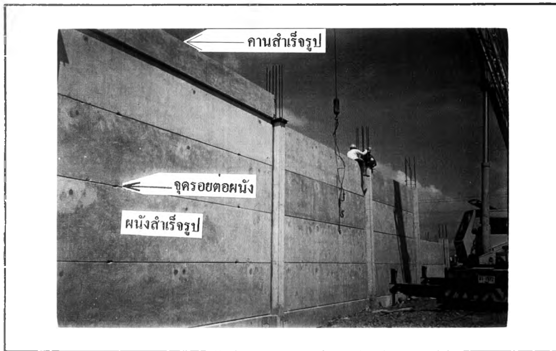
รูปที่ 3.37 ภาพถ่ายระหว่างผนังสำเร็จรูปกับเสาและคานสำเร็จรูป
