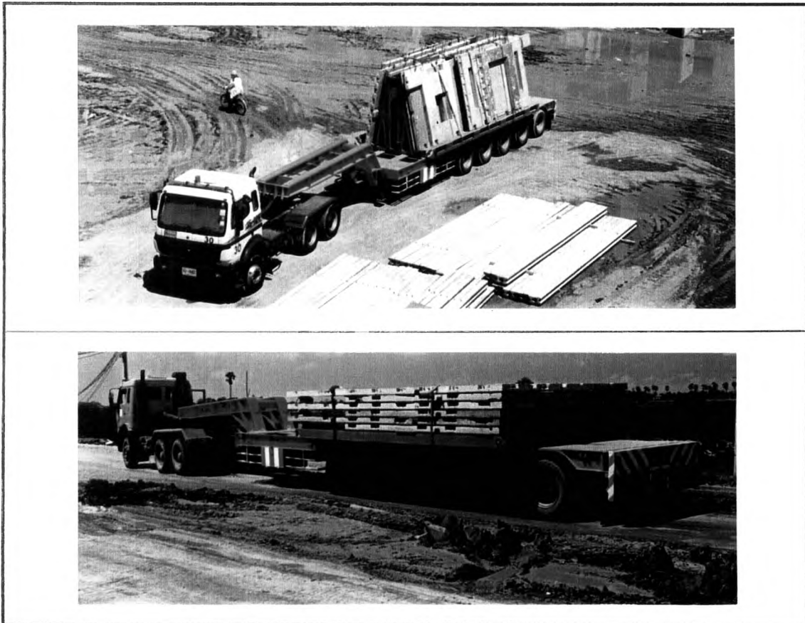
รูปที่ 3.13 การขนส่งแผ่นผนังสำเร็จรูป (บน) และแผ่นพื้นสำเร็จรูป (ล่าง)
