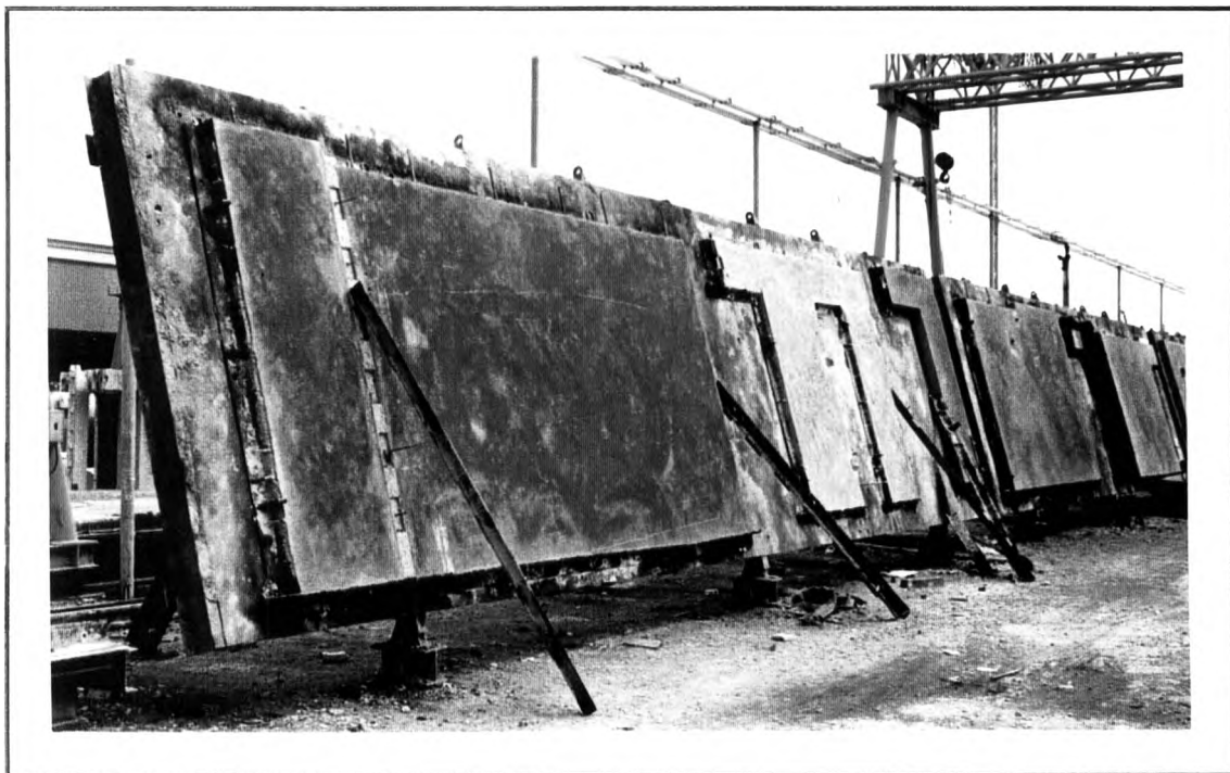
รูปที่ 3.7 แสดงลักษณะแบบหล่อขึ้นส่วนสำเร็จรูปที่สามารถยกได้ โครงการ ง
