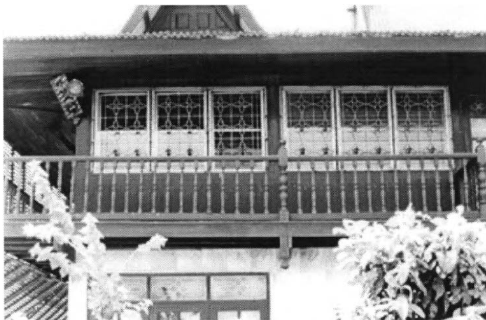
การติดกระจก และเหล็กดัดที่บานหน้าต่างเรือนไทย
