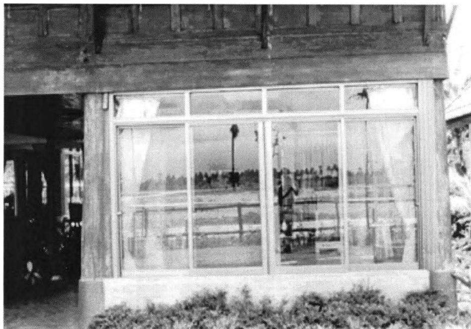
การใช้วัสดุสมัยใหม่ในบางส่วนของเรือนไทย เช่น บานหน้าต่างอลูมิเนียม กับกระจกติดตั้งกับเรือนไทยไม้
