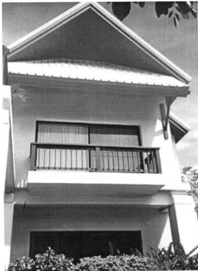
การมีชายคายื่นคลุมตัวบ้านและมีค้ำยัน
