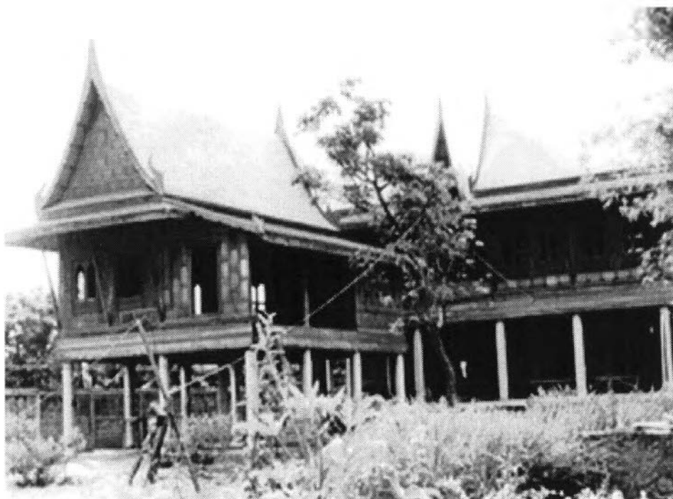
การใช้โครงสร้างคอนกรีตเสริมเหล็กตรงเสาเรือนชั้นล่างแทนไม้อย่างเดิม
