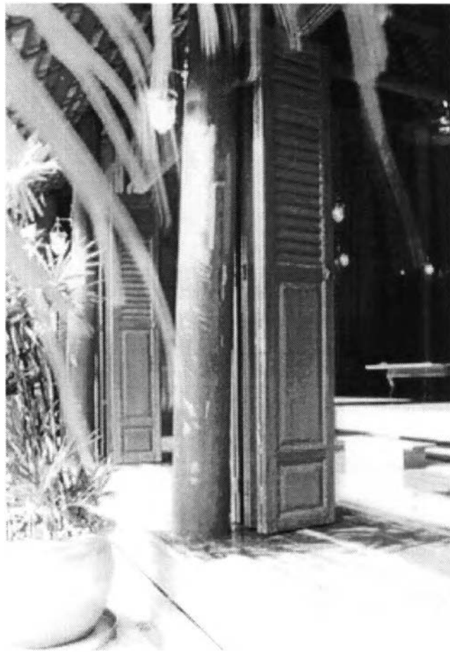
แสดงการทำประตูเป็นลักษณะผนังที่เปิดกว้างได้หลายบาน
