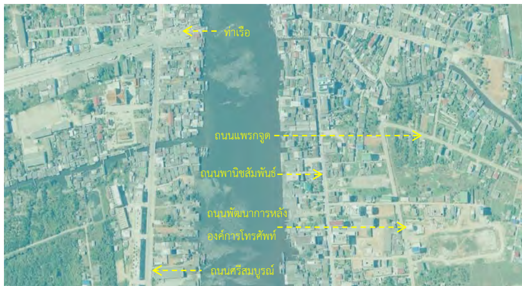
รูปที่ 97 ภาพถ่ายทางอากาศ พ.ศ.2545
