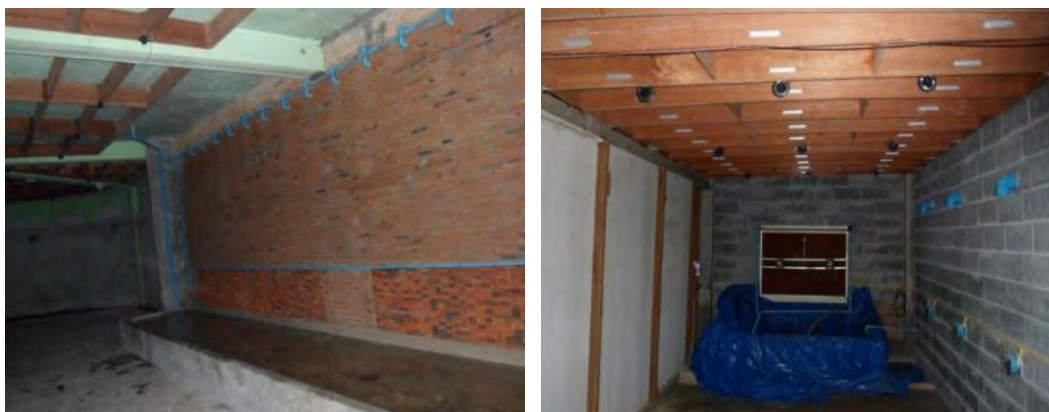
รูปที่ 59 ผนังก่ออิฐมอญหรืออิฐบล็อกไม่ฉาบปูนเพื่อรักษาความชื้นภายในอาคาร (นริญ เลขสุข, 2556)
