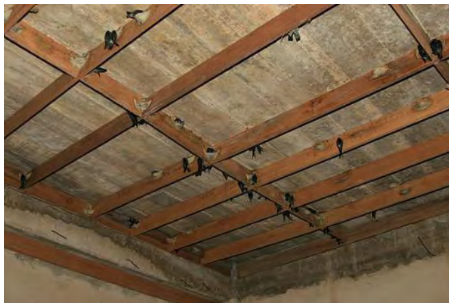
รูปที่ 65 ไม้ตีรังสำหรับนกเกาะรัง (เทพชัย อริยะพันธุ์, 2551b)
