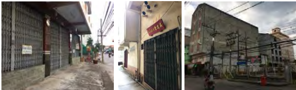
รูปที่ 113 ชั้นล่างอาคารสำหรับนกแอ่นทำรัง เจ้าของอาคารปล่อยพื้นที่ชั้นให้เช่า
