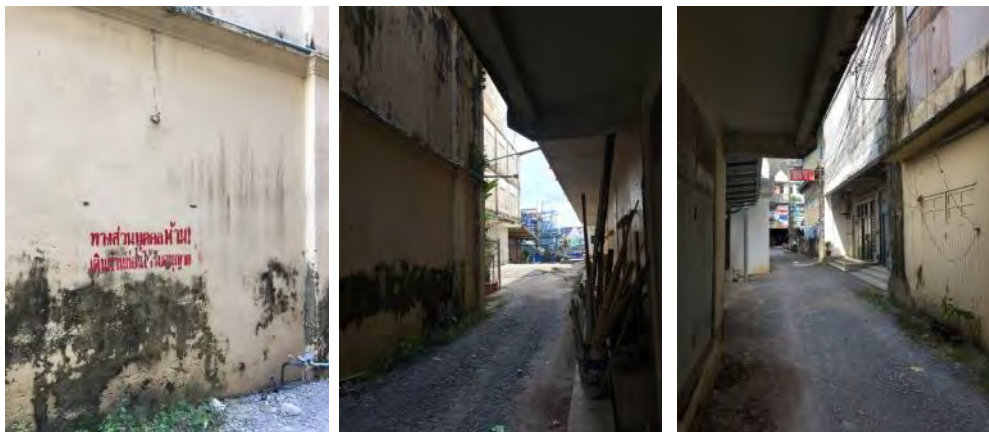
รูปที่ 106 ซอยที่ในอดีตอนุญาตให้ผู้คนสัญจรผ่านได้ ปัจจุบันมีการสร้างอาคารสำหรับนกแอ่นทำรังในซอย มีการควบคุมความปลอดภัยโดยห้ามผู้คนสัญจรผ่าน
