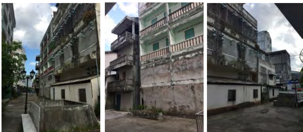
รูปที่ 108 ถนนทางเดินक्रमคลองบางว่า ปัจจุบันเป็นอาคารสำหรับนกแอ่นทำรังตลอดสองข้างถนน
