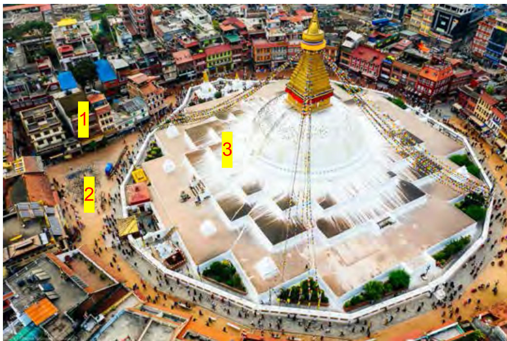
ภาพที่ 3.39 ส่วนฐานพระสถูปเจดีย์รูปแปดเหลี่ยม
