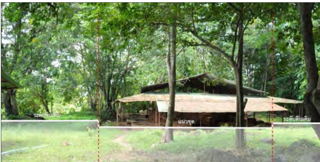
ภาพที่ 119 แสดงระดับดินเดิม แนวจุด ก่อนการปรับปรุง
