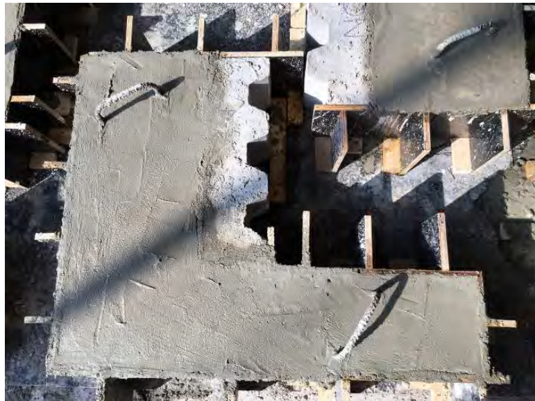
รูปที่ 3.7 แบบหล่อชิ้นส่วนตัวอย่างทดสอบหลังเท
