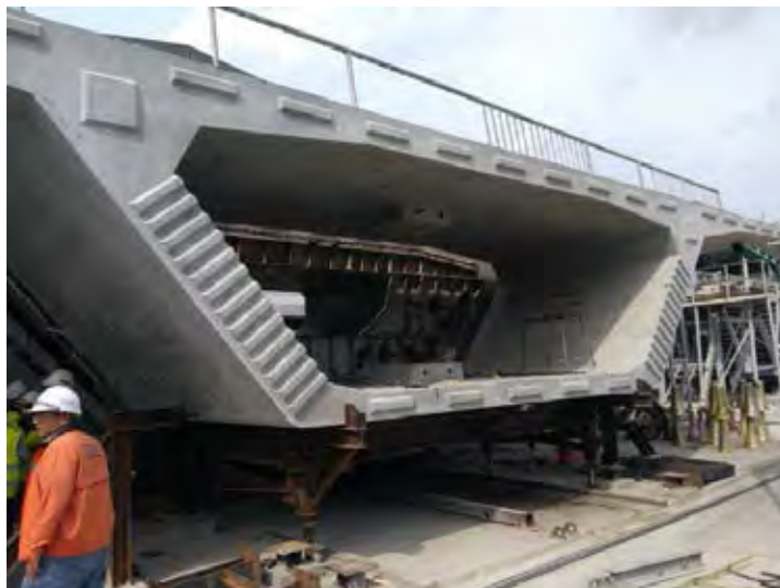
รูปที่ 1.1 ชิ้นส่วนคอนกรีตอัดแรงประเภทกล่อง
