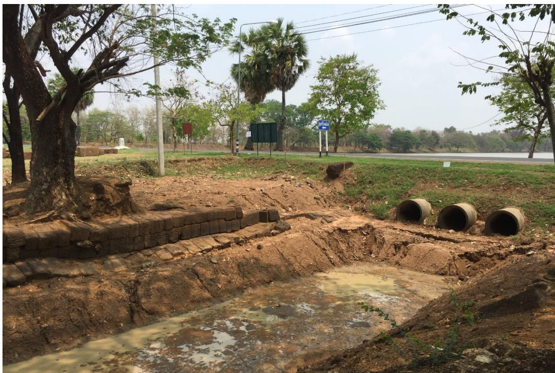
ภาพที่ 35 สะพานขอม ทางระบายน้ำออกจากบารายเมืองต่ำ ภาพถ่ายสำรวจ: เมื่อวันที่ 19 มีนาคม 2563
