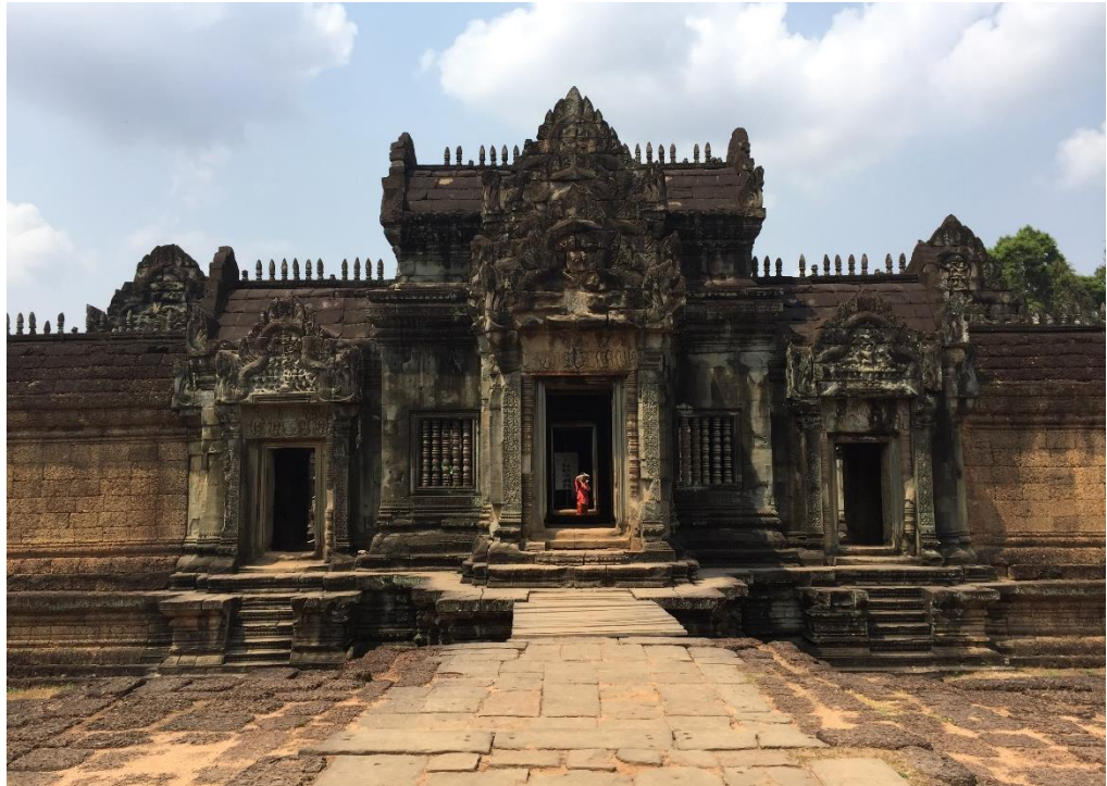
ภาพที่ 105 แนวแกนปราสาทด้านหน้ากำแพงชั้นนอก ปราสาทบันทายสําเหร์ ภาพถ่ายสำรวจ: เมื่อวันที่ 3 มีนาคม 2563
