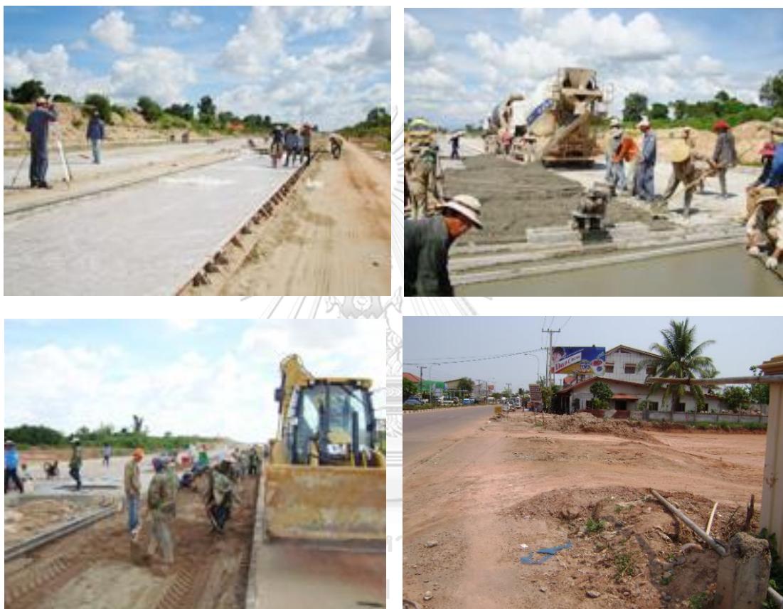
ภาพที่ 36 การก่อสร้างถนน 450 ปี
