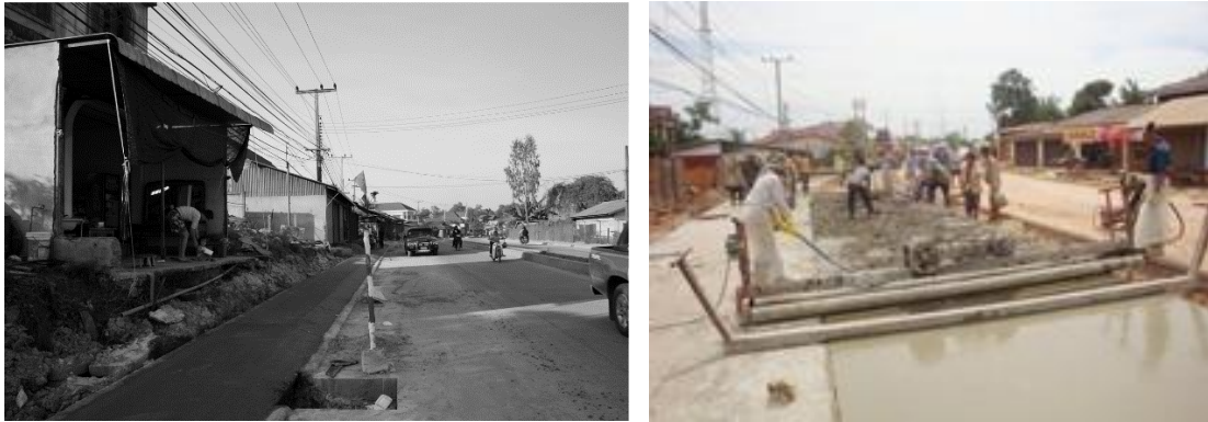
ภาพที่ 48 ถนนโพนด้อย – ดงโคก ในระหว่างการก่อสร้างปี ค.ศ.2009
