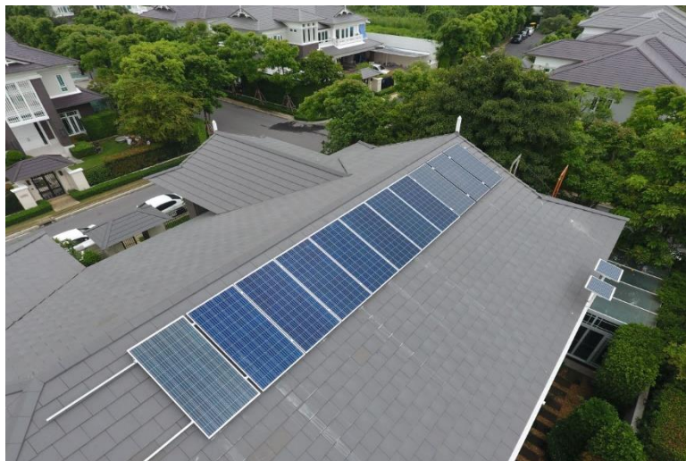
รูปที่ 2.4 การติดตั้งแผงโซลาร์เซลล์บนหลังคา [21]
