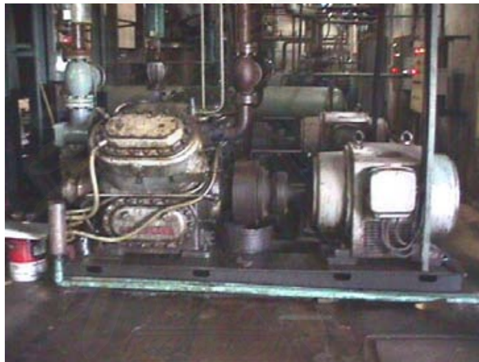
รูปที่ 3.1 คอมเพรสเซอร์ของชุดระบบทำความเย็น
