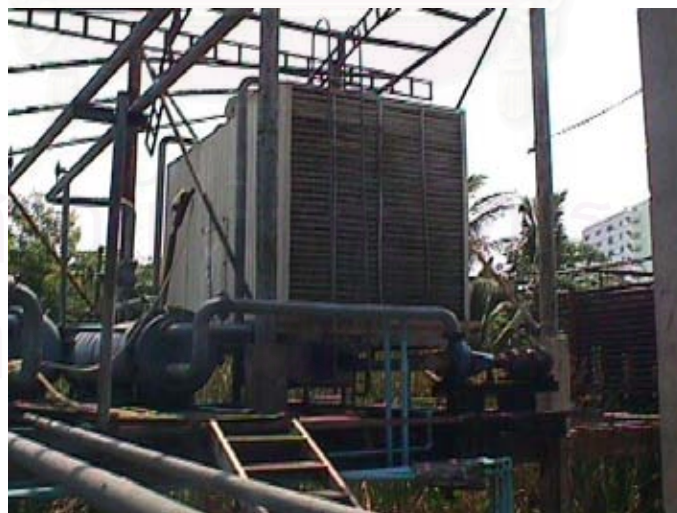
รูปที่ 3.2 คอนเดนเซอร์ของชุดระบบทำความเย็น
