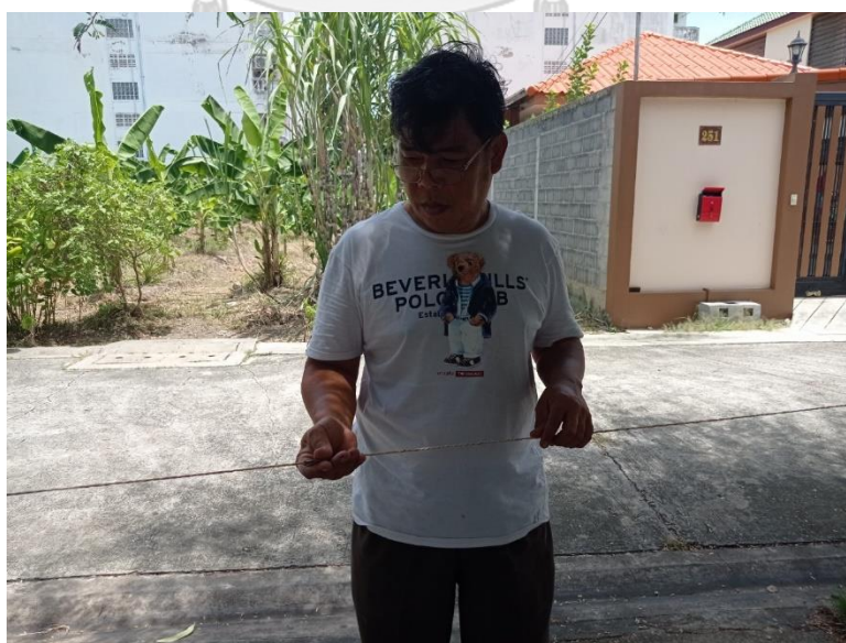
ภาพที่ 85 การขัดไส้ละมานด้วยกระดาษทราย
