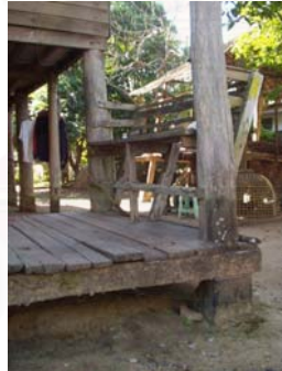
พื้นยกกระดานก่อนขึ้นบันได
