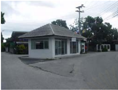
บริเวณกลางบ้าน ลานสินค้าชุมชนก่อนปรับปรุง
