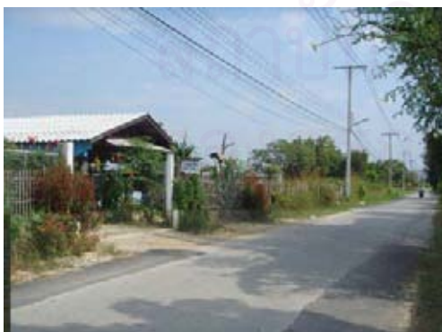
บริเวณเส้นทางสัญจรในชุมชนก่อนปรับปรุง
